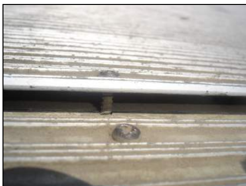
Figura 5-9 Pérdida de remaches y tornillos.
