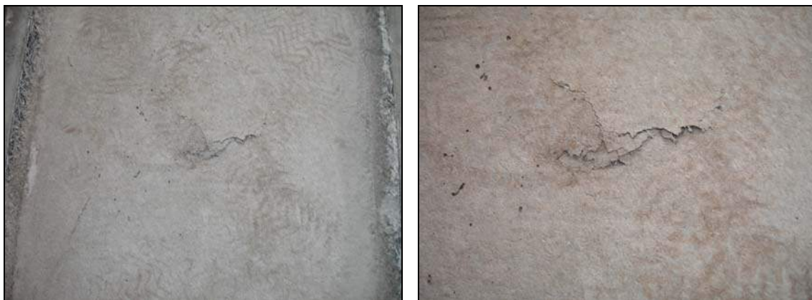
Figura 8.4 17 Mecanismo de falla ensayo de punzonamiento (Continuación)
