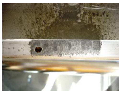
Figura 5-55 Desgaste en apoyos en láminas reinstaladas.
