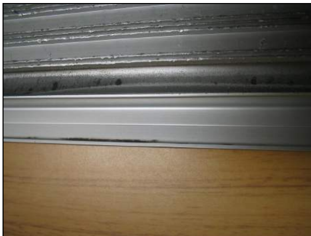
Figura 5-44 Desgaste dentro de la canal del mismo perfil descrito arriba pero a mitad de distancia entre puntos de sujeción.
