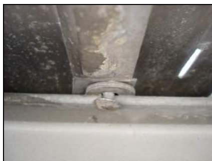
Figura 5-7 Anclajes desajustado.
