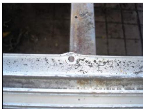
Figura 5-56 Exceso de perforaciones en láminas reinstaladas.
