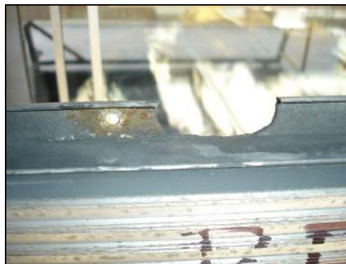
Figura 5-54 Desgaste en apoyos en láminas reinstaladas.
