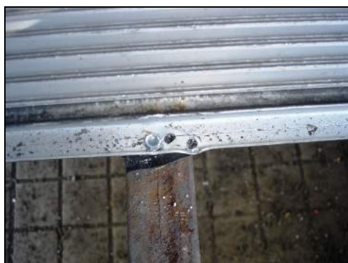
Figura 5-56 Exceso de perforaciones en láminas reinstaladas.
