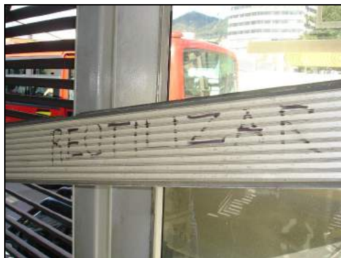
Figura 5-54 Desgaste en apoyos en láminas reinstaladas.
