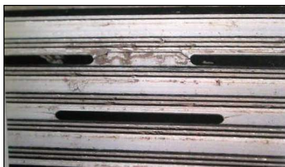
Figura 5-32 Detalle de las fracturas presentadas en los perfiles perforados, 2002
