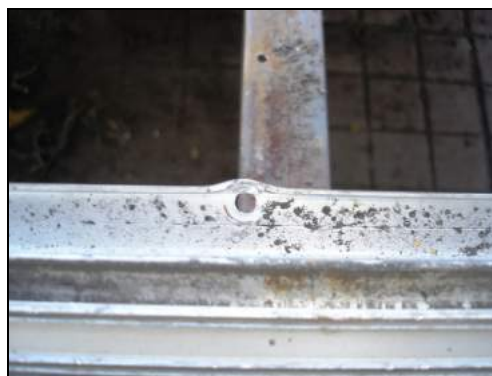
Figura 5-9 Pérdida de remaches y tornillos.
