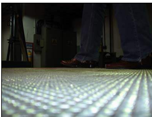
Figura 8.6-22 Medición de ruido condición No 2
