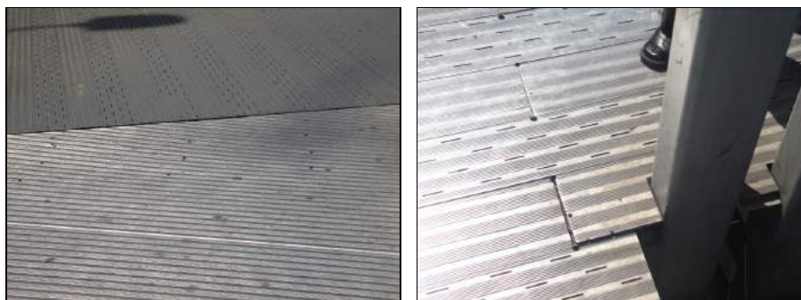
Figura 5-11 Corrimientos de láminas.
