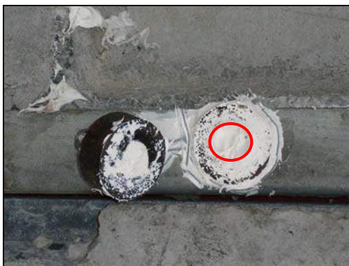
Figura 8.9-17 Ensayo de tensión en pega elástica sobre acero del módulo de GRC
