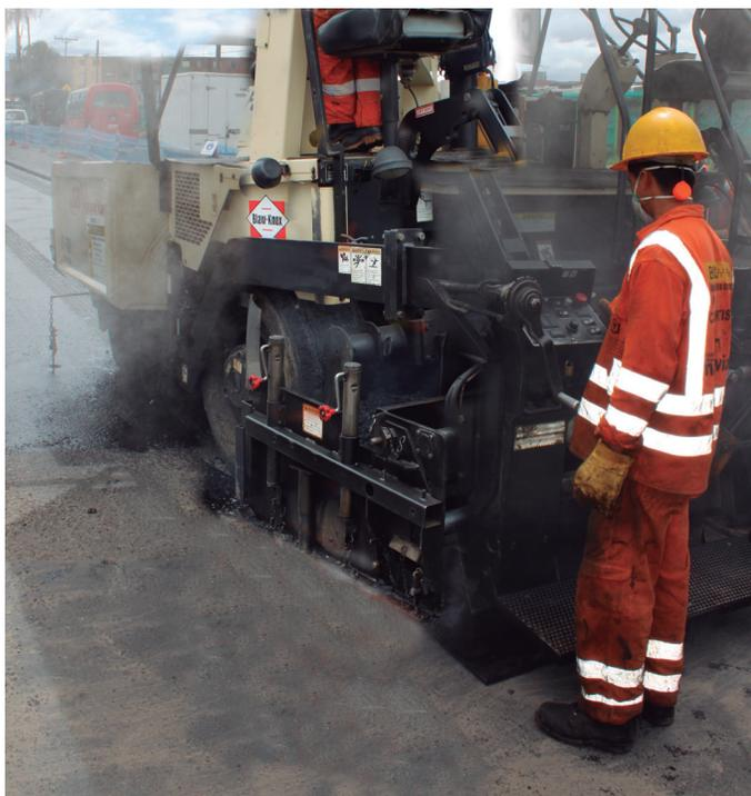
Ref: Instalación de mezcla asfáltica en caliente.
