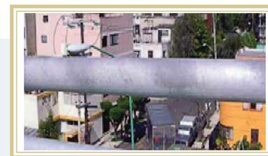
Figura 33. Acabado baranda galvanizada con gris opaco o mate. Fuente: LATIZA. "Guía para la Galvanización en caliente".
