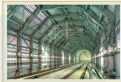
Figura 72. Sistema estructural de metro galvanizado.
