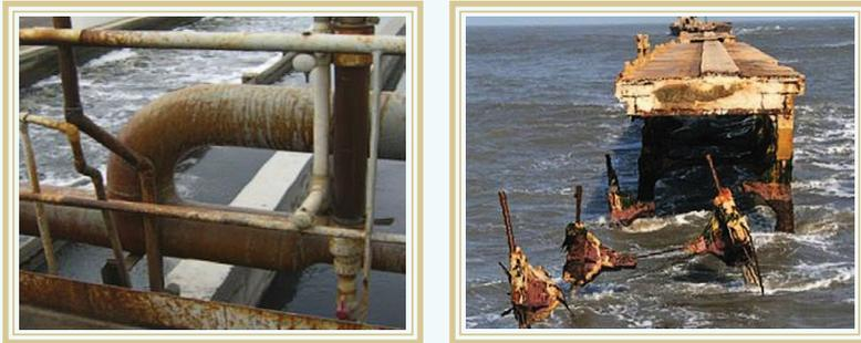
Figura 7. Tubería oxidada planta de tratamiento y muelle corroído. Fuente: El Heraldó
