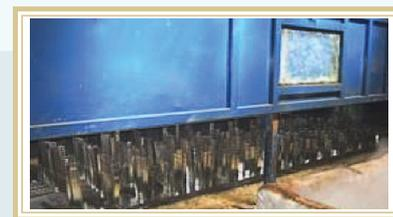
Figura 42. Campana de extracción de humos, cuba de galvanizado en Bogotá.
