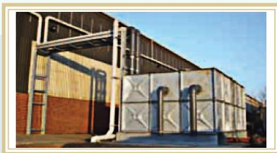
Figura 43. Tanques de almacenamiento de aguas lluvia para reutilización.
