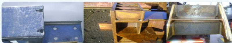
Figura 14. Muestra de destijeres adecuados en estructura metálica
