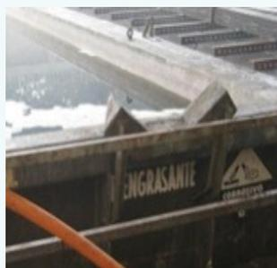
Figura 20. Tanque de desengrase - Planta galvanizadora. Fuente: ANDI, Cámara Fedemetal, Comité de Galvanizadores
