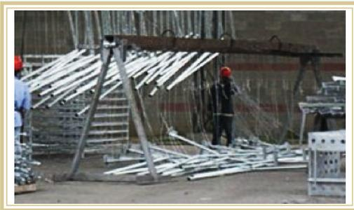
Figura 27. Desamarre de estructuras galvanizadas e inspección visual del material.
