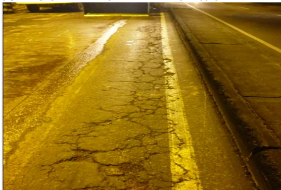
ANTES Av. CARRERA 68 ENTRE CALLES 16 Y 18 COSTADO ORIENTAL CARRIL LENTO 21/01/14
