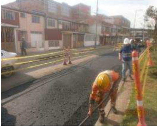
Colocación de mezcla asfáltica MD-20 en el carril oriental de la calzada occidental. Venecia Avenida carrera 54 entre DG 45 sur y Tv 44 sur CIV 6000476
