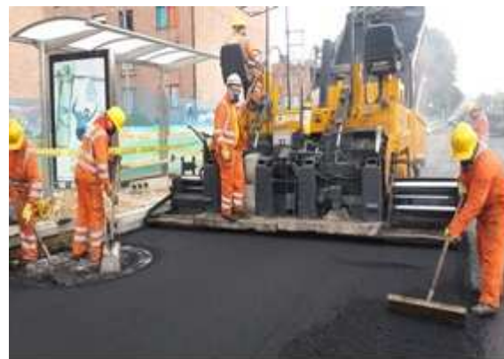
Carrera 15 por Calle 127, Costado Oriental. Instalación Mezcla Asfáltica MD-20.
