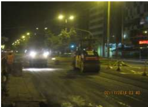
Carrera 15 por Calle 127, Costado Oriental. Instalación Mezcla Asfáltica MD-20.
