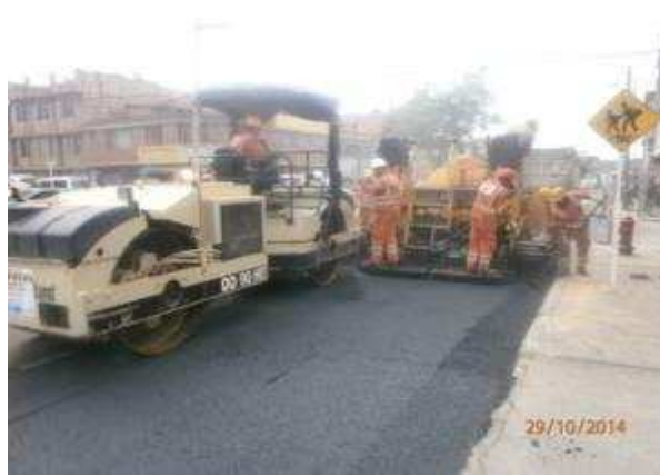
Colocación de mezcla asfáltica con asfalto caucho en carril occidental de la calzada occidental Venecia Avenida carrera 54 entre DG 45 sur y Tv 44 sur CIV 6000355 - 6000430 - 6000476
