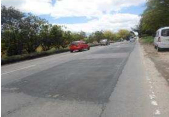
Acciones de Movilidad Autopista norte entre CII 207 a CII 215
