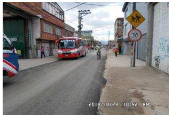
ESTADO DE LA VIA DESPUES DE LA INTERVENCIÓN
