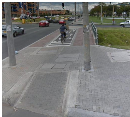
RAMPAS EN CICLORRUTAS
