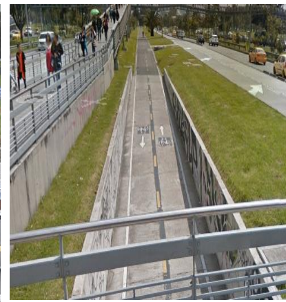
CICLORRUTA SOBRE SEPARADOR
