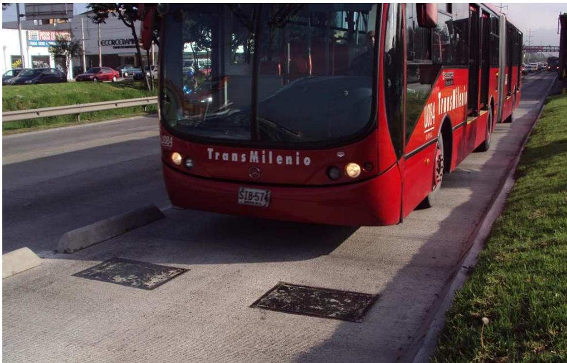
**Figura 5.3.** Tramo de pavimento rígido instrumentado en operación: se observan las placas de pesaje dinámico de vehículos (WIM)
