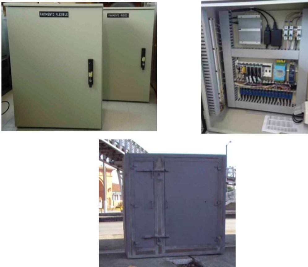
**Figura 2.1.** Caseta metálica que contiene los equipos de adquisición de datos y caja de concreto que contiene dicha caseta en campo.
