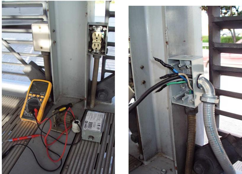
**Figura 5.2.** Ejemplo del proceso de adaptación para suministro de energía a la caseta de instrumentación
