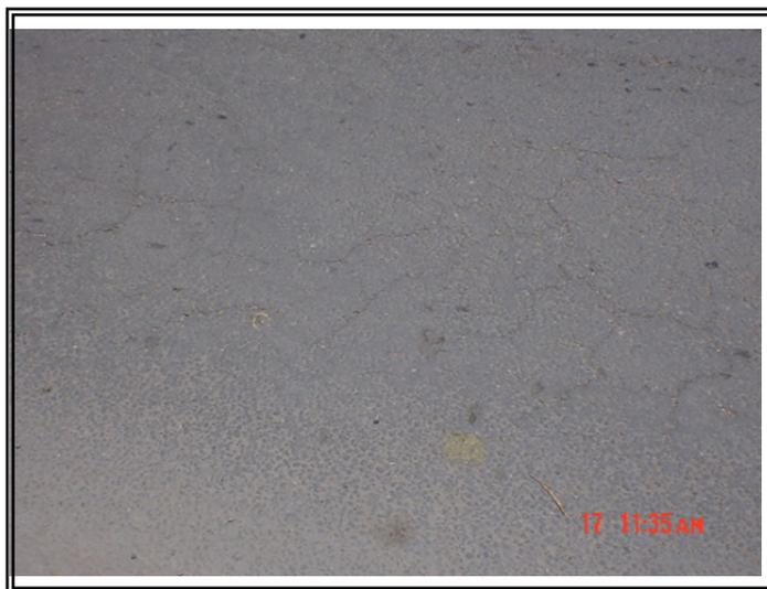
**Figura 10.49. Tramo de pista con polímero SBR, se observan fisuras en forma de piel de cocodrilo.**
