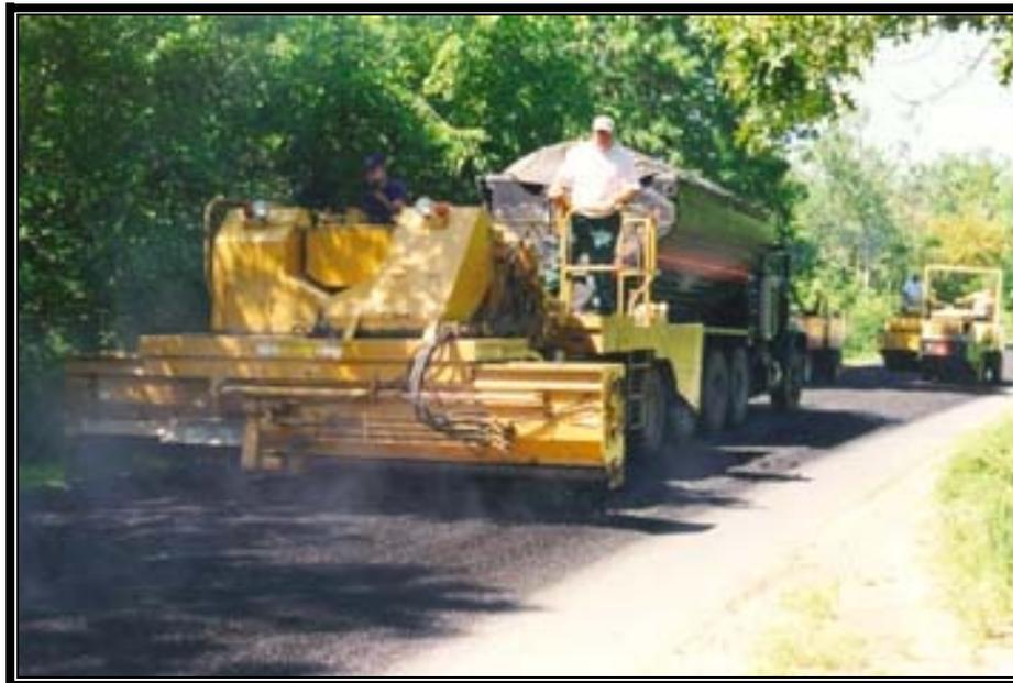
**Figura 4.8. Aplicación de asfalto-caucho en un tratamiento superficial. Tomado de:**
