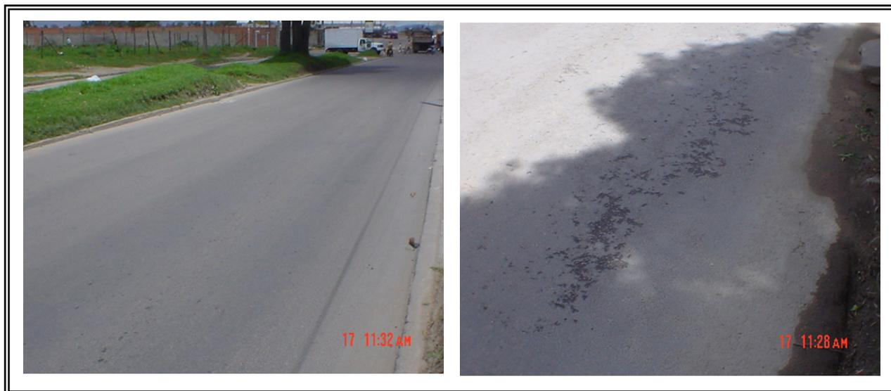
**Figura 10.48. Tramo de pista Vía Húmeda. A izquierda se observa peladuras.**
