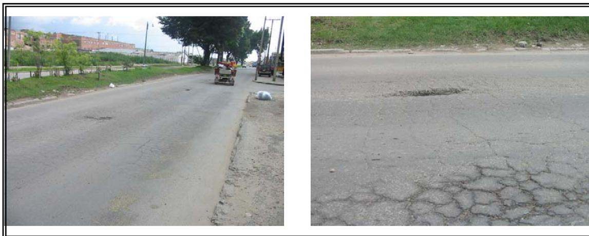
**Figura 10.63. Tramo con asfalto caucho modificado por proceso vía seca.**
