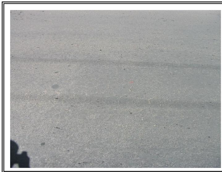
**Figura 10.58. Fotografía Junio de 2005 tramo vía húmeda, mallado de grietas.**
