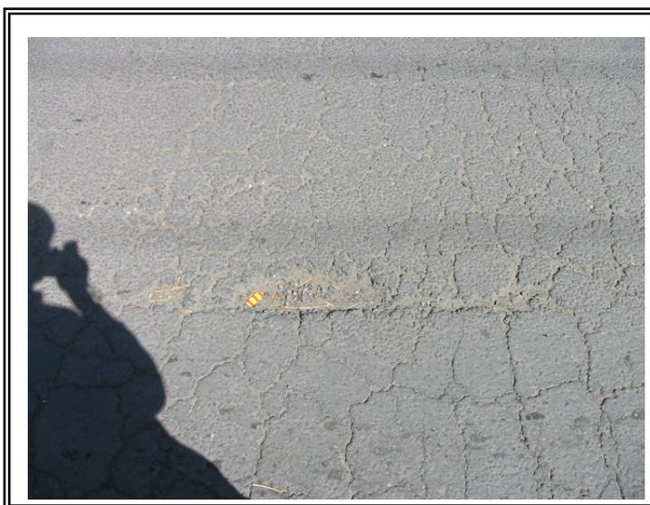
**Figura 10.54. Fotografía Junio de 2005 tramo vía seca, se aprecia formación de bache.**
