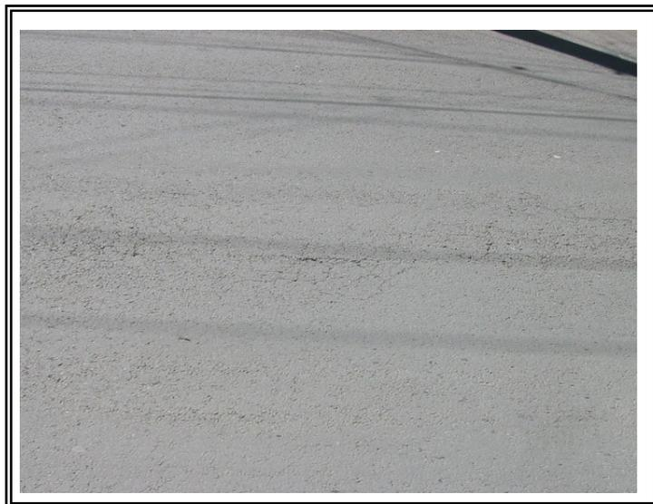
**Figura 10.56. Fotografía Junio de 2005 tramo con polímero SBS, se aprecia agrietamiento con tendencia a formación de mallas.**
