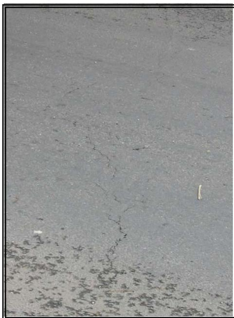
**Figura 10.50. Fisura de tipo transversal atraviesa toda la calzada SBR**
