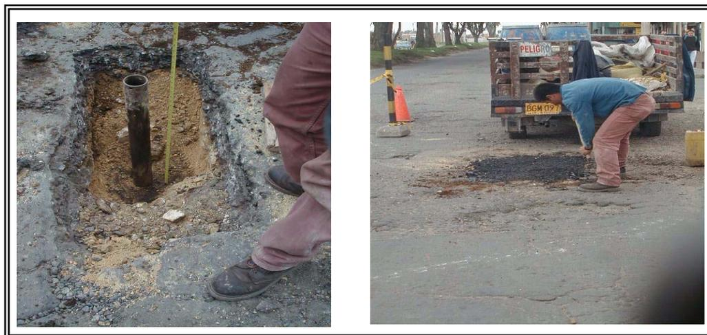
**Figura 7.3. Toma de muestra de subrasante y colocación de mezcla asfáltica en el apique No. 1**
