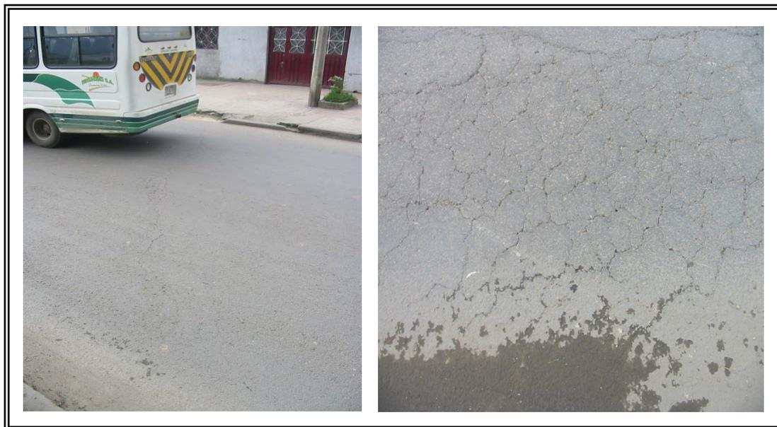
**Figura 10.67. Tramo con asfalto modificado comercial con polímero SBR.**
