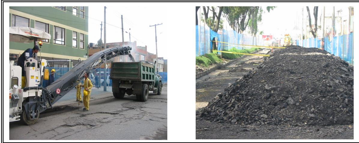
La primera etapa para la construcción de la pista de prueba fue el fresado, el cual consistió en cortar 17 cm del pavimento existente, mezclar 10 cm de material fresado con la base existente, y botar los 7cm restantes con el fin de mantener las cota iniciales de rasante.
