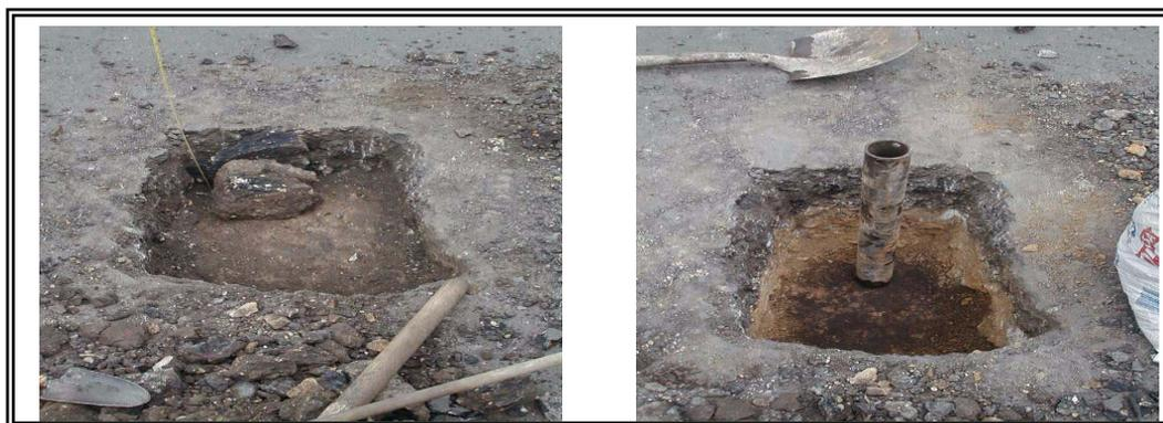
**Figura 7.5. Toma de muestra de subrasante y aspecto de la base asfáltica**
