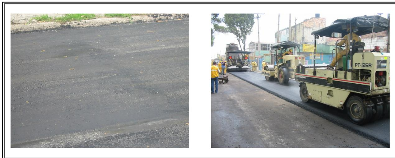
Para esta mezcla la temperatura de llegada de la mezcla fue de 164°C y la de compactación de 154°C.
