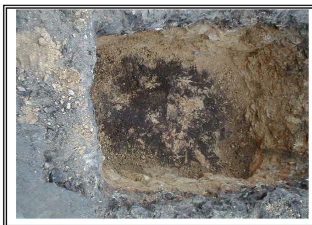
Figura 7.7. Colocación de la mezcla asfáltica en el apique No. 3 y aspecto de la subrasante existente
