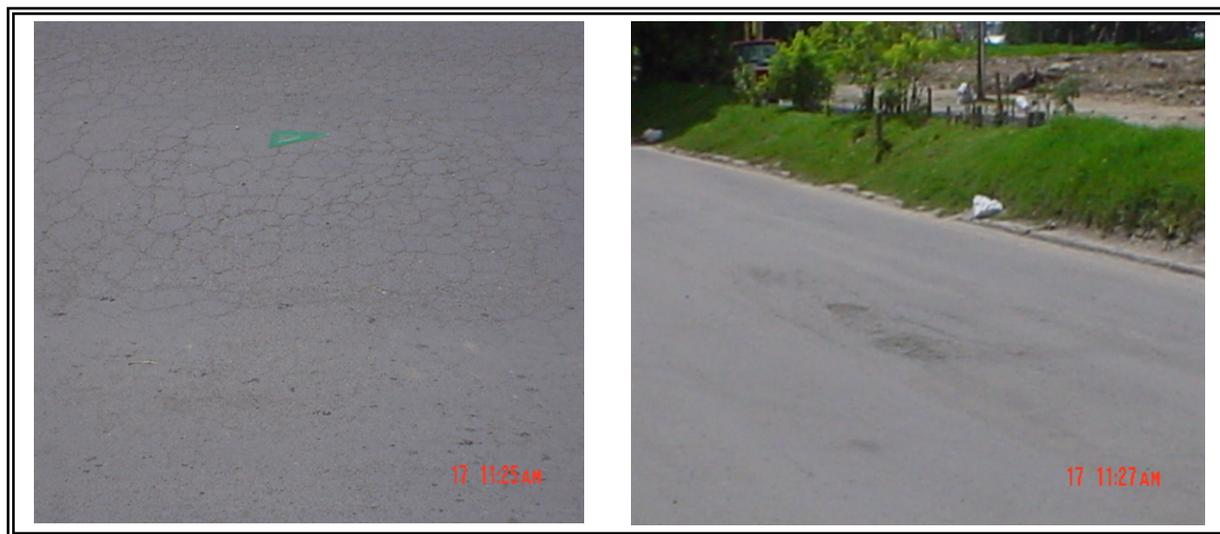
**Figura 10.47. Se observa piel de cocodrilo e inicio de desprendimiento de material.**
