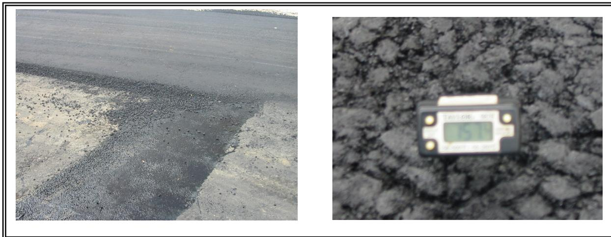
Para esta mezcla la temperatura de llegada de la mezcla fue de 161°C y la de compactación de 155.6°C.
