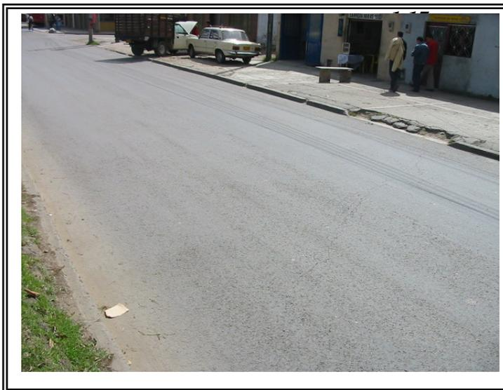
**Figura 10.59. Fotografía Junio de 2005 tramo con polímero SBR, se aprecia fisuramiento transversal a lo ancho de la calzada.**
