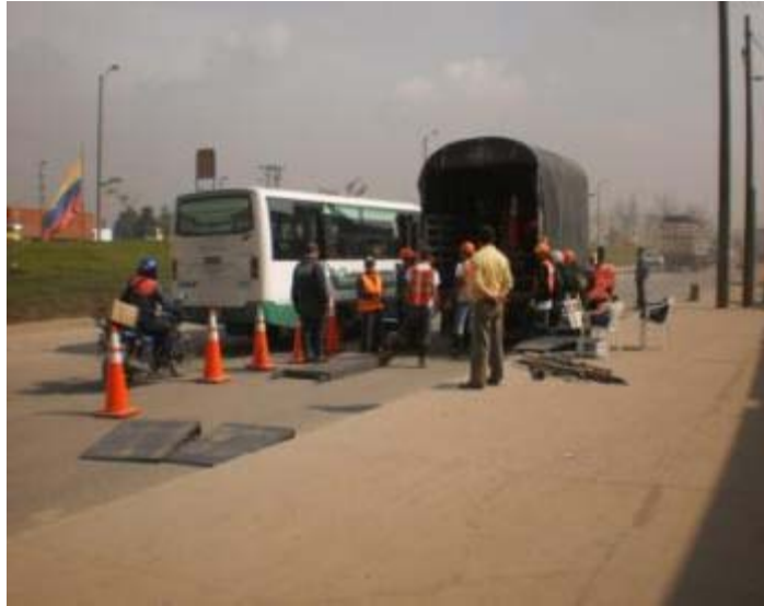
Imagen 4-9. Descargue e Instalación de las básculas.
