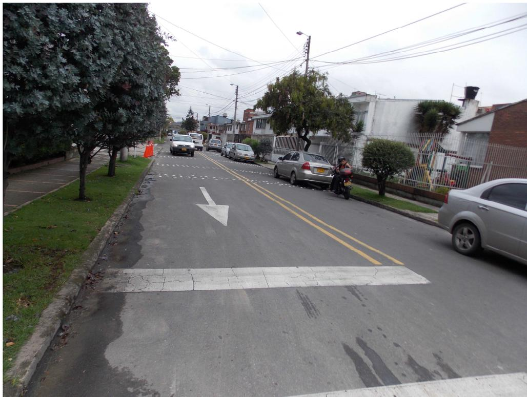
Figura 7.1 Pavimento flexible en vías locales
