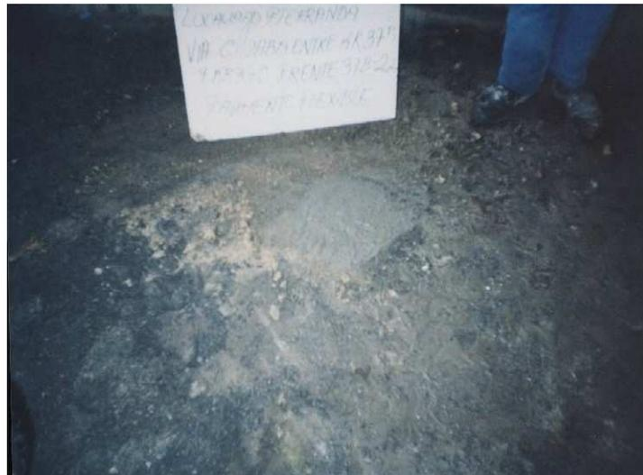
**Figura 61. Reparación de la capa de rodadura.**
