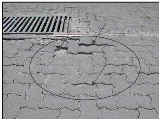
**Figura 41. Escalonamiento en pavimentos adoquinados.**
