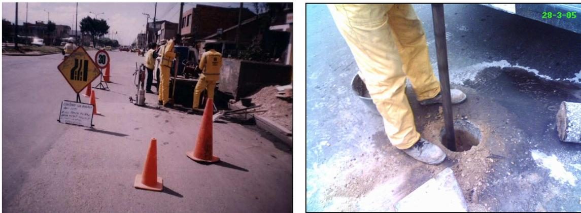
**Figura 58. Profundización de perforación en pavimento flexible.**
