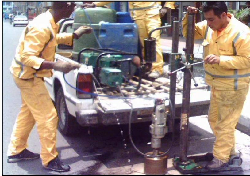
Figura 56. Taladro y Planta eléctrica empleadas para la extracción del núcleo.
