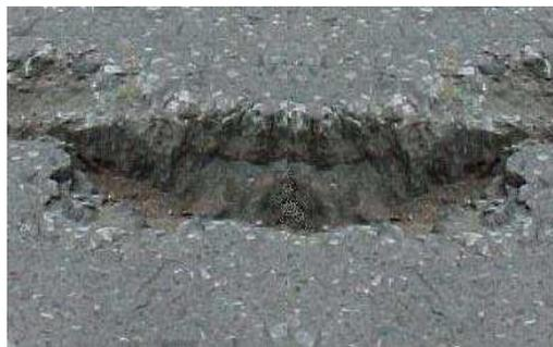
**Figura 36. Bache en pavimento rígido**
