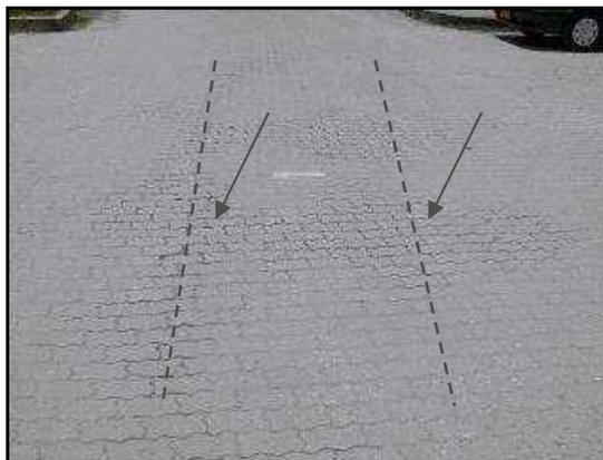
**Figura 37. Ahuellamiento en pavimentos adoquinados.**
