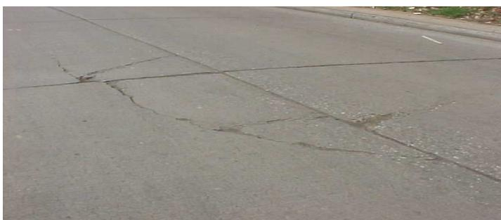
**Figura 34. Fisura de Esquina**
