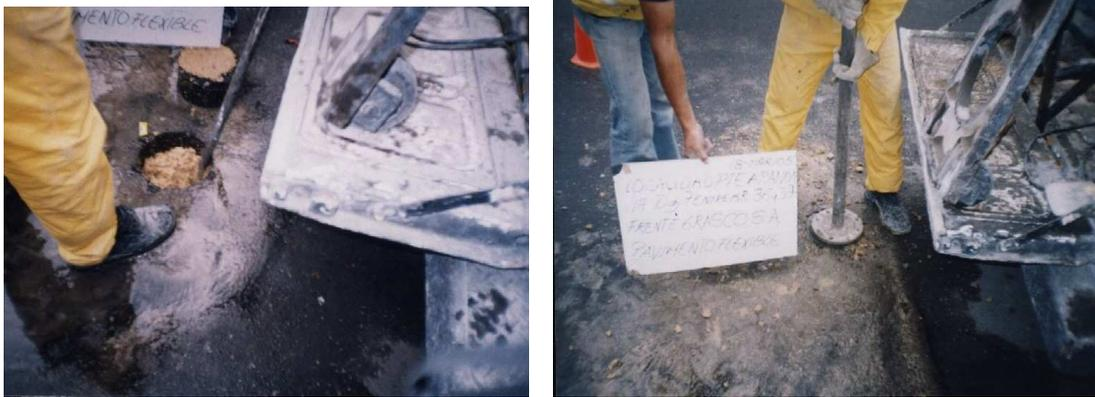
**Figura 60. Reparación de las Capas Granulares**
