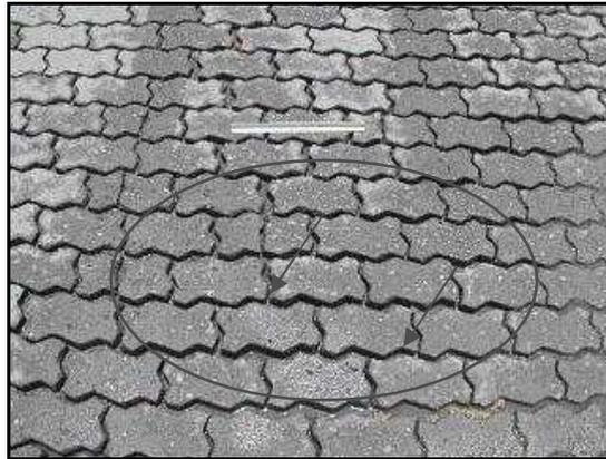
**Figura 38. Desunión en pavimentos adoquinados.**
