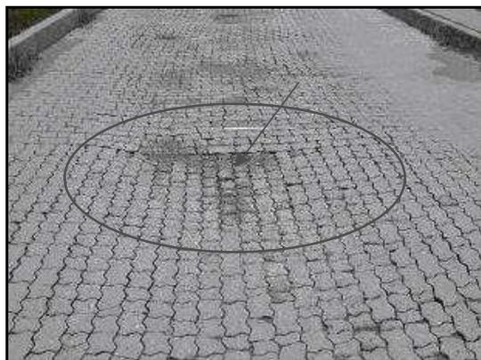
**Figura 42. Ondulaciones y hundimientos en pavimentos adoquinados.**
