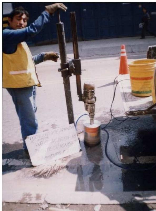
**Figura 57. Extracción del núcleo.**
