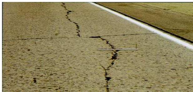
**Figura 33. Fisuras en pavimento rígido**
