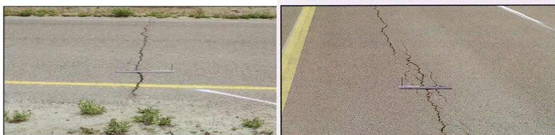
**Figura 23. Fisuras en pavimento flexible**
