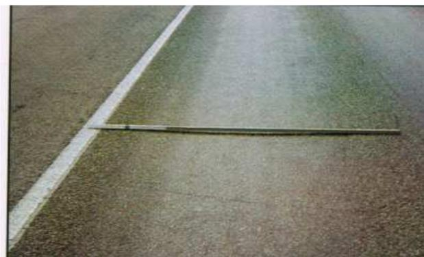
**Figura 25. Ahuellamiento en el pavimento flexible**
