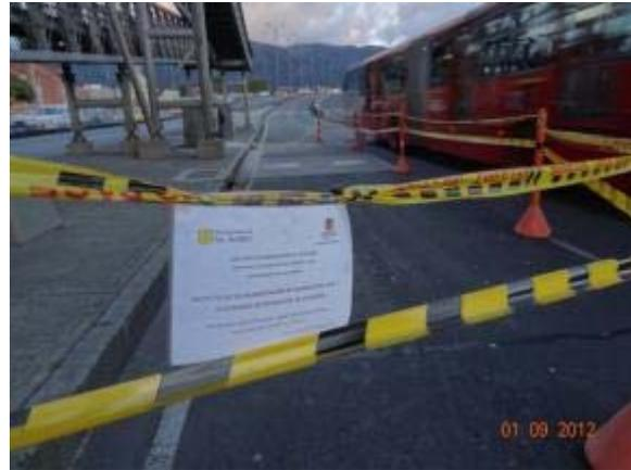
**Figura 5.28.** Fotografía panorámica del cierre implementado para garantizar curado.
