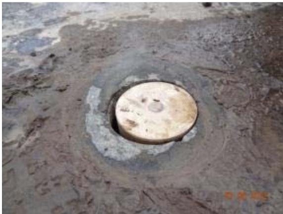
**Figura 5.8.** Núcleo falso de madera, para protección temporal de la perforación.
