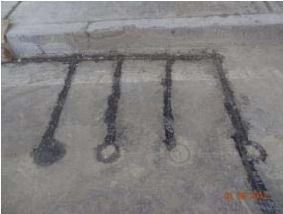
**Figura 5.27.** Aspecto final de los núcleos instalados y las zanjas de cableado.
