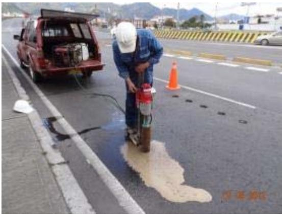
**Figura 5.6.** Corte de los núcleos de las capas asfálticas – Sistema “Calle 80”.
