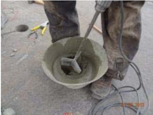
**Figura 5.23.** Preparación del mortero epóxico.
