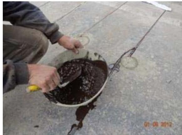
**Figura 5.26.** Sellado e impermeabilización de las ranuras de cableado.
