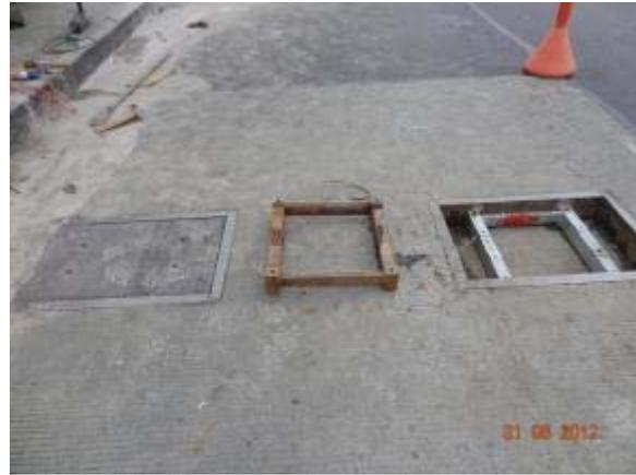
**Figura 5.4.** Izq: WIM tapada, centro: marco deteriorado, der: WIM destapada, marco nuevo.
