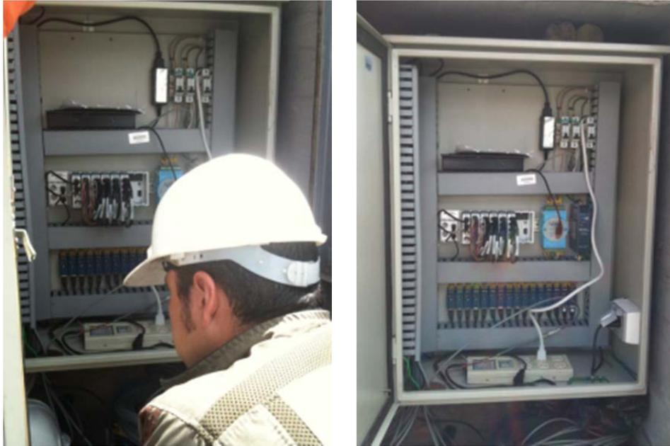
**Figura 3.7.** Caja metálica con instrumentos de captura de datos. Procedimiento de puesta a punto luego de su conexión al punto de corriente eléctrica.
