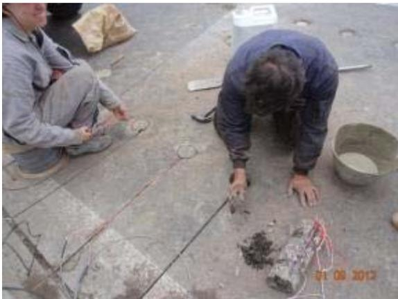
**Figura 5.25.** Instalación de núcleos y cableado.
