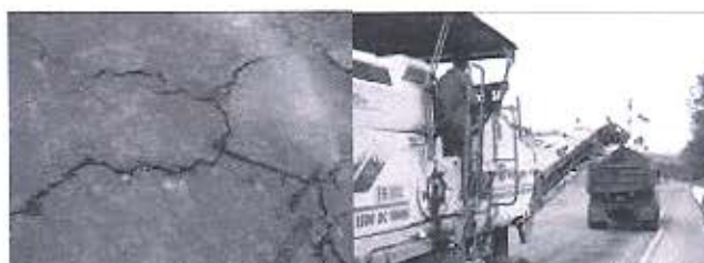
Figura 45 – Sellado de Fisuras Fuente: Cortesía Comité Técnico de Geosintéticos
