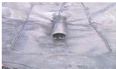
Figura 42 – Extrusión en el panel de la geomembrana Fuente: Cortesía Comité Técnico de Geosintéticos
