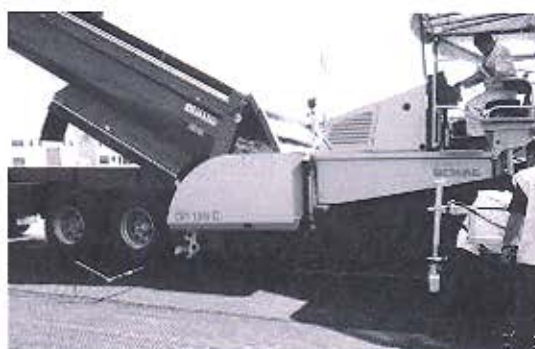
Figura 49 – Aplicación del Concreto Asfáltico Fuente: Cortesía Comité Técnico de Geosintéticos
