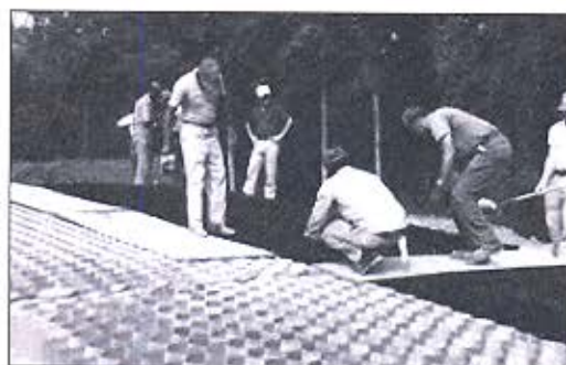
Figura 2 – Colocación de Geosintéticos en la Construcción de Vías en EE.UU, década de los 50.
