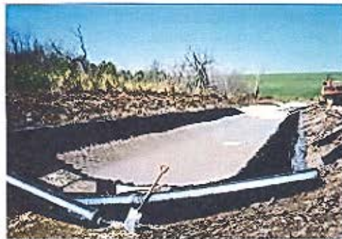
Figura 80. Geocelda para protección de canales Fuente: Cortesía Comité Técnico de Geosintéticos
