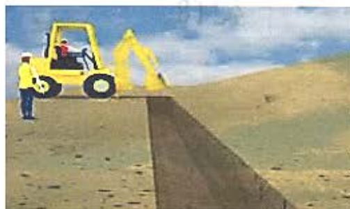
Figura 24 – Excavación para Subdren Fuente: Cortesía Comité Técnico de Geosintéticos
