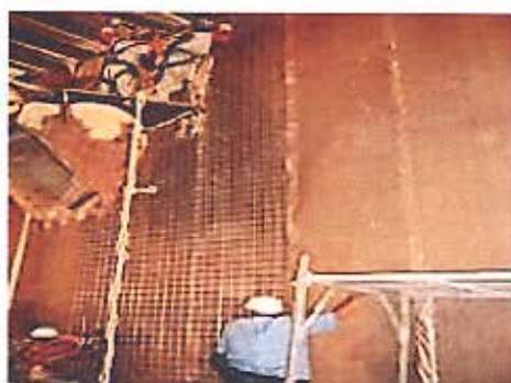
Figura 29 – Impermeabilización de Túneles Fuente: Cortesía Comité Técnico de Geosintéticos
