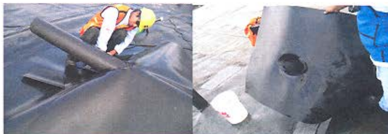
Figura 39 – Proceso final de la extrusión
