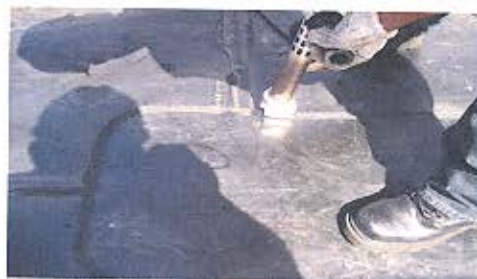
Figura 34 – Proceso de Extrusión Fuente: Cortesía Comité Técnico de Geosintéticos
