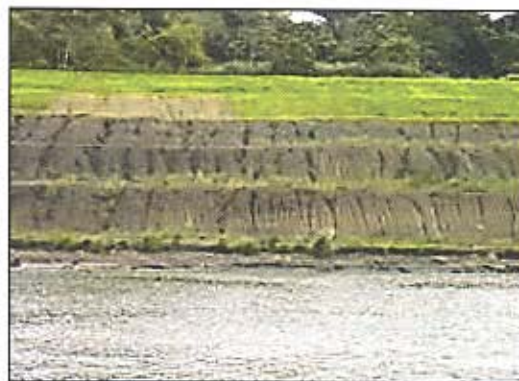
Figura 69. Erosión por surcos Fuente: Cortesía Comité Técnico de Geosintéticos
