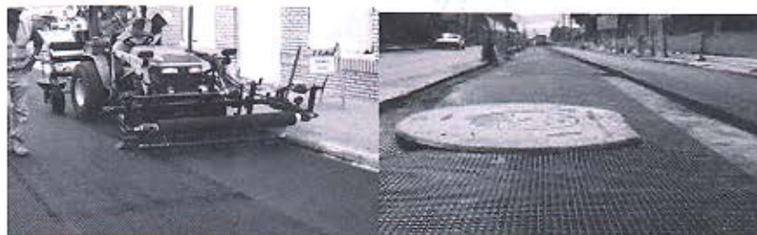
Figura 47 – Instalación de Geomalla Fuente: Cortesía Comité Técnico de Geosintéticos
