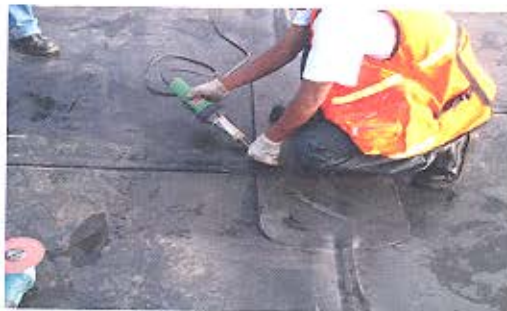
Figura 32 – Soplador de Aire Caliente Fuente: Cortesía Comité Técnico de Geosintéticos
