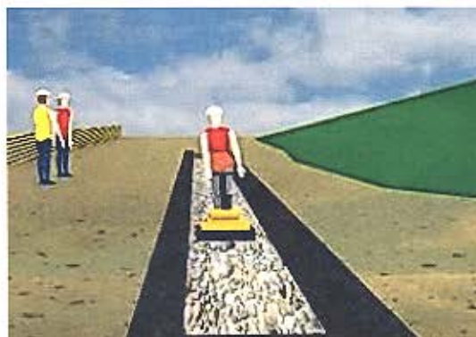
Figura 25 – Compactación de Material Drenante Fuente: Cortesía Comité Técnico de Geosintéticos
