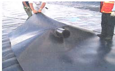
Figura 36 – Agujero del mismo diámetro de la Tubería Fuente: Cortesía Comité Técnico de Geosintéticos
