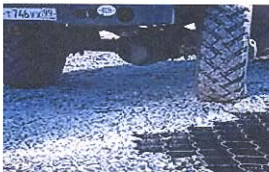
Figura 78. Geocelda como soporte de carga Fuente: Cortesía Comité Técnico de Geosintéticos
