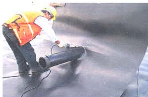
Figura 37 – Fijar con el soplador de Aire Caliente Fuente: Cortesía Comité Técnico de Geosintéticos
