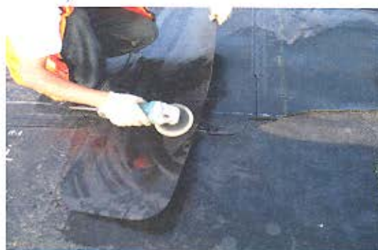
Figura 31 – Desbastar el perímetro de la Geomembrana Fuente: Cortesía Comité Técnico de Geosintéticos
