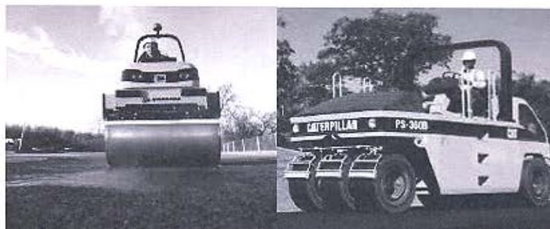
Figura 50 – Compactación de la Geomalla con el Concreto Asfáltico Fuente: Cortesía Comité Técnico de Geosintéticos
