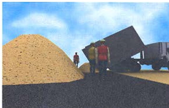
Figura 58 – Material Granular sobre la geomalla Fuente: Cortesía Comité Técnico de Geosintéticos
