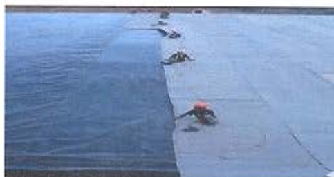
Figura 30 – Instalación de Geomembranas Fuente: Cortesía Comité Técnico de Geosintéticos
