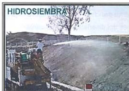
Figura 73. Instalación de Hidro-siembra en un talud Fuente: Cortesía Comité Técnico de Geosintéticos
