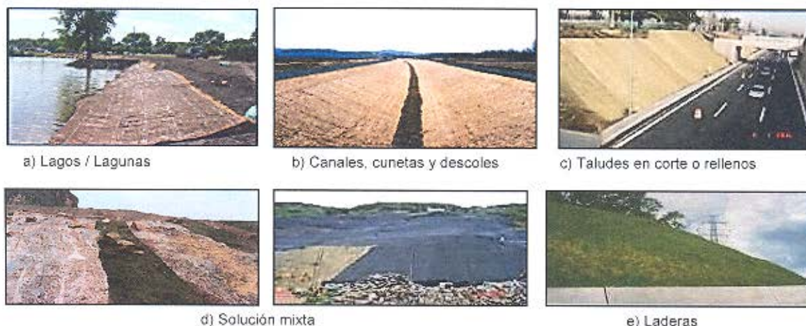
Figura 71. Aplicación de los productos PECE temporales y permanentes
