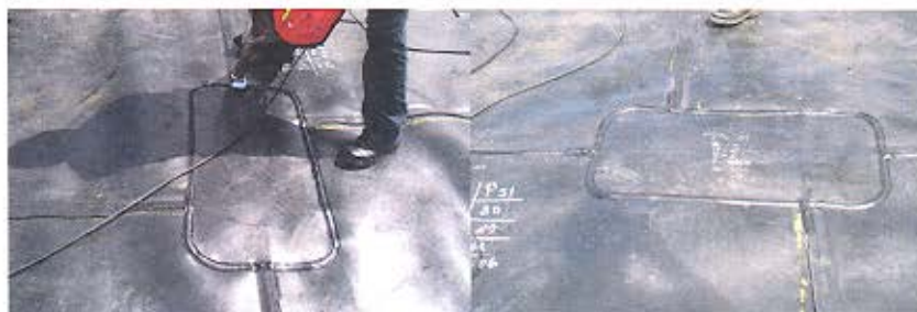
Figura 35 – Enmienda con encuentro de Soldadura Fuente: Cortesía Comité Técnico de Geosintéticos
