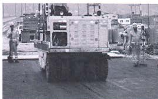
Figura 48 – Mejoramiento de Adherencia de la Geomalla Fuente: Cortesía Comité Técnico de Geosintéticos
