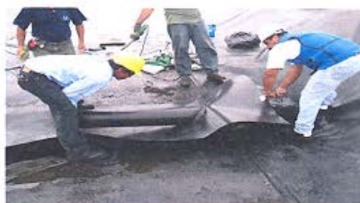
Figura 40 – Recubrimiento total de la tubería
