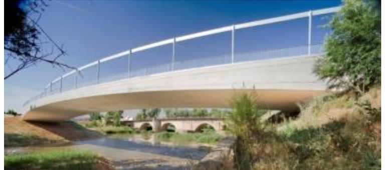
Figura 8. Barandas galvanizadas del puente vehicular.
