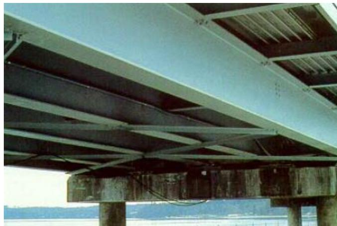
Figura 10. Estructura para puente vehicular galvanizada.
