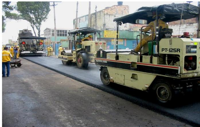
Además, permite mencionar en forma precisa las formas técnicas, operativas y resultados obtenidos a partir de la utilización de mezcla asfáltica modificada con Grano de Caucho Reciclado (GCR) sobre algunos tramos viales de la ciudad. Esto para facilitar su análisis y presentación, el cual puede servir a otras partes involucradas en el manejo de este residuo que genera una problemática en la ciudad.
