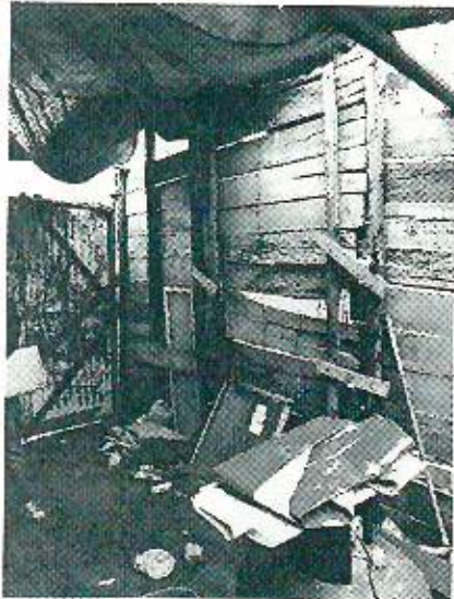
INTERIOR DEL PREDIO
