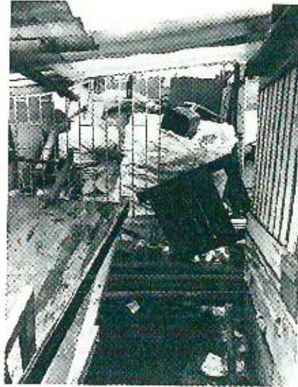
INTERIOR DEL PREDIO
