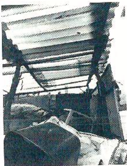
INTERIOR DEL PREDIO
