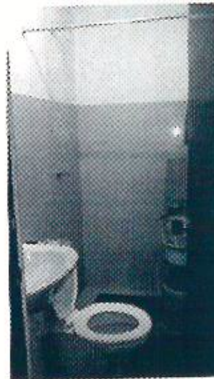
BAÑO SEGUNDO PISO
