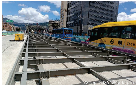
Fotografía N° 12. Instalación de la estructura metálica del piso de la pasarela central entre los vagones N°1 y N°2 de la estación BRT N°18 carrera 53.
