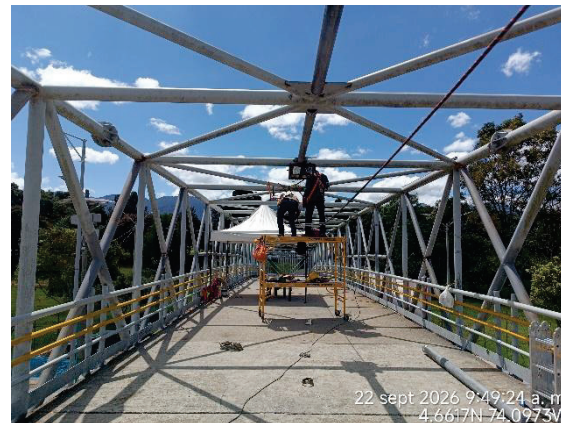
Fotografía N° 6. Se observó la instalación de elementos de refuerzo estructural del puente peatonal Simón Bolívar.
