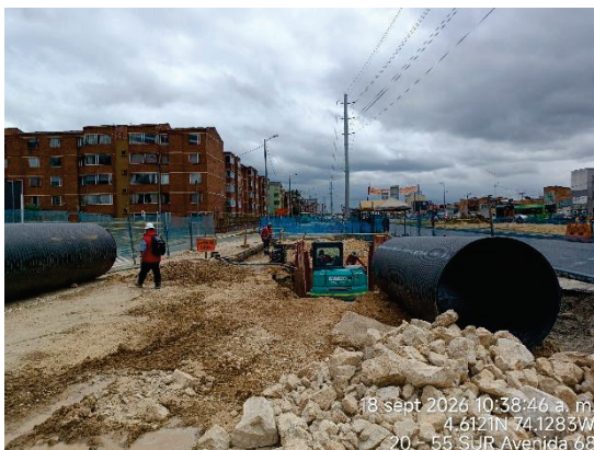
18 sept 2026 10:38:46 a. m. 4.6121N 74.1283W 20-58 SUR Avenida 68 Fotografía N° 27. Avance de la instalación del colector y material de confinamiento en la calzada de tráfico mixto entre empalme grupo 2 de la troncal Av. 68 e intersección Av. 1 de mayo, costado occidental. Las actividades descritas se observaron entre las calles 22 sur y 20 sur.
