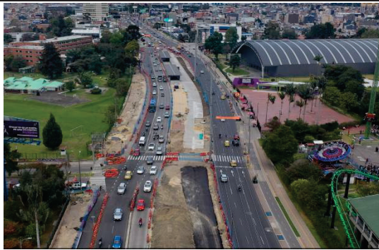
Fotografía N° 25. Panorámica vista al norte del avance en la construcción del espacio público y calzadas mixtas y BRT en el sector entre Salitre Mágico y el empalme con el grupo 7.
