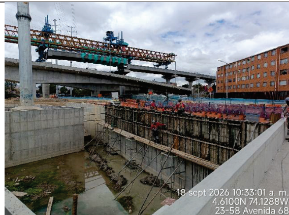
Fotografía N° 24. Vista hacia el occidente de avance de estructura de contención y deprimido adyacente a la taquilla externa TQ-9. Conexión con estación 7 PLMB (Av. Primero de mayo / av. 68 – carrera 52C). Se observó que se instaló acero de refuerzo y fundición de concreto de los muros perimetrales hacia la calzada vehicular del costado occidental.
