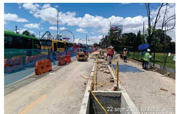
Fotografía N° 22. Se observó el avance en la construcción de contenedores de raíces, instalación de subbase granular y sardineles en concreto en el espacio público frente la estación BRT N°13 Calle 66 en el costado occidental.
