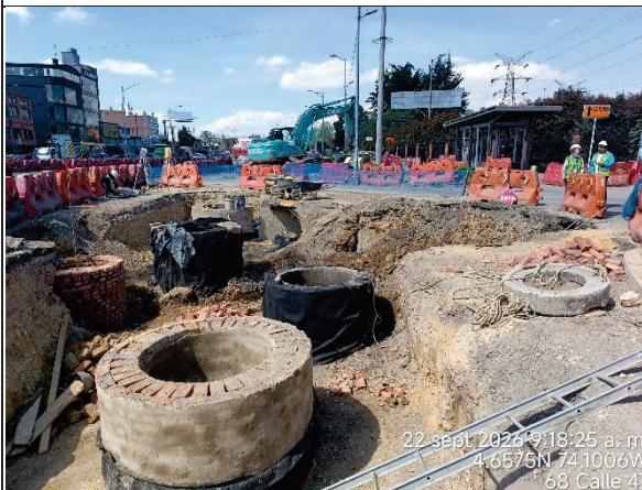
Fotografía N° 5. Avance en las obras de empalme con el grupo 5, se observó la construcción de pozos de inspección de aguas lluvias y sanitarias en el carril de vehículos mixtos en el costado occidental en la calle 47.
