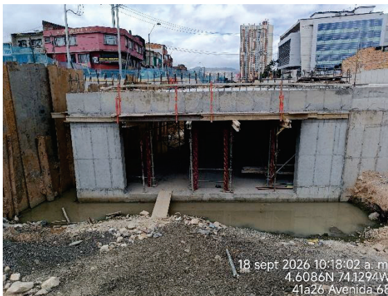
Fotografía N° 23. Vista hacia el sur, avance de estructura de contención y deprimido adyacente a la taquilla externa TQ-9. Conexión con estación 7 PLMB (Av. Primero de mayo / av. 68 – carrera 52C). Se observó que realizó la fundición de la placa superior del deprimido en el costado sur oriental.
