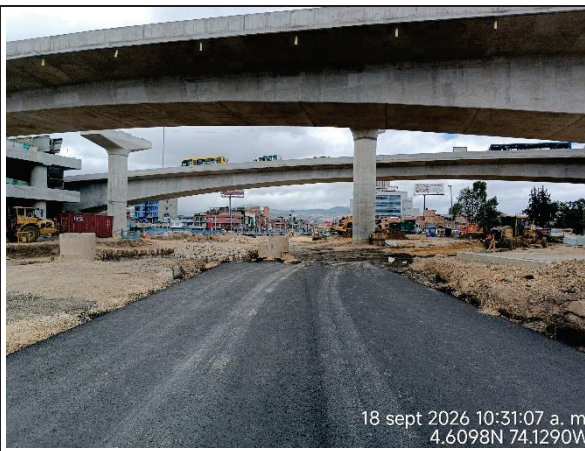
18 sept 2026 10:31:07 a. m. 4.6098N 74.1290W Fotografía N° 28. Estación BRT #3 – tipo específico estación, que corresponde a la estación que conecta con la PLMB (estación 7); la obra del box que conecta la estación Av. Primero de Mayo con la PLMB, de acuerdo con el PDT, con corte al 14/09/2026, continúa con un avance del 96.58%. Durante el recorrido se observó que ya se instaló mezcla asfáltica que sirve de capa antierosiva en la calzada BRT.
