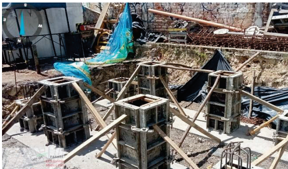
Fotografía N° 17. Taquilla adyacente al ciclo parqueadero de la estación Avenida Suba. Se observó la construcción de la cimentación y pedestales en concreto. De acuerdo con el PDT con corte al 14/09/2026, la actividad de construcción de las 5 taquillas de la Av. Suba continúa con un avance del 14.65%.
