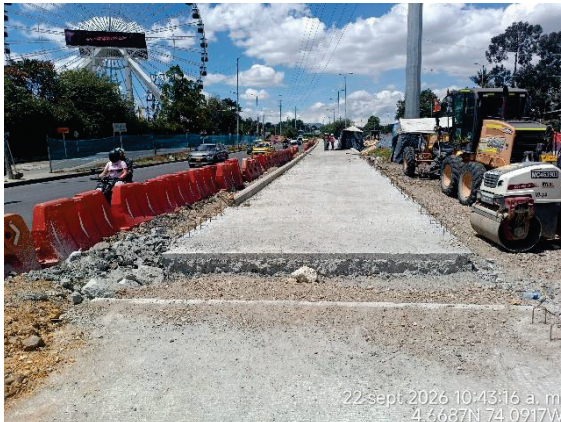
Fotografía N° 23. Se observó la instalación de concreto MR45 en el carril BRT oriental frente a Salitre Mágico.
