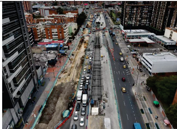
Fotografía N° 20. Vista aérea hacia el occidente del sector entre el empalme con el grupo 9 y el puente de la troncal Av. Suba sobre la troncal Av. 68.
