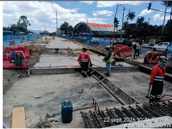
Fotografía N° 14. Vista hacia el norte, avance en la construcción de calzadas BRT y mixto costado oriental entre calles 52 y 63. Se observó la instalación de barras de transferencia y preparación de formaleta para fundición de concreto MR45. De acuerdo con el PDT con corte al 14/09/2026, para el corredor BRT entre las calles 46 y 66 se tiene un avance del 89.38%.
