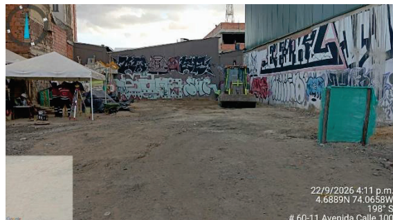
Fotografía N° 14. Se observó la adecuación de la plataforma para la construcción de ciclo parqueadero y taquilla de la estación BRT #17 (Av. Suba). De acuerdo con el PDT, con corte al 14/09/2026, el avance en la ejecución del hito "ciclo parqueadero" es de 4.24%.
