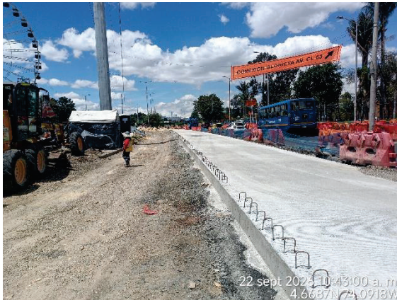
Fotografía N° 17. En la calzada BRT, frente a salitre mágico, se observó la instalación de concreto MR45.
