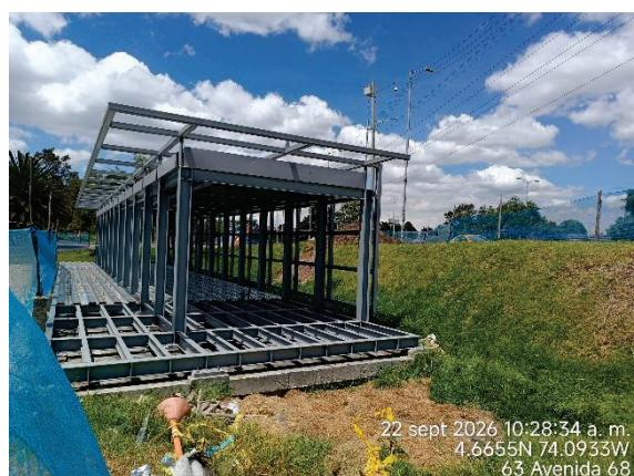
Fotografía N° 16. Se observó la instalación de la estructura del ciclo parqueadero en el acceso norte – oriente de la estación BRT #12 Simón Bolívar. De acuerdo con el PDT con corte al 14/09/2026, tiene un avance del 55.47%.
