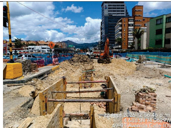
22 sept 2026 12:56:46 p.m. 4.6883N 74.0629W 49-03 Avenida Calle 100 Fotografía N° 18. Se observó en el sector 8 (calzada sur mixtos y espacio público) entre la Av. Suba y empalme con el grupo 9, el inicio del reemplazo de la red de alcantarillo de diámetro 8" para aguas negras y para aguas lluvias en diámetro de 24". De acuerdo con el PDT con corte al 14/09/2026, la actividad de redes húmedas (colector, red matriz, sanitario, pluvial) tiene un avance del 85.12%.
