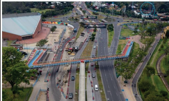
Fotografía N° 26. Panorámica del bici puente, en la última semana de agosto se habilitó este puente tanto para el paso peatonal como de biciusuarios.
