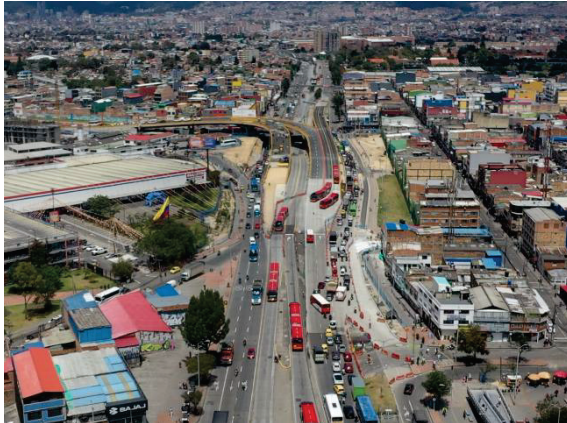
Fotografía N° 1. Panorámica puente Venecia – vista hacia oriente. De acuerdo con el PDT con corte al 14/09/2026, la actividad “ Construcción intersección elevada puente occidente-oriente (eje3), puente occidente-norte (eje 4) y puente norte-occidente (eje 6, desde estribo norte hasta pila 3) ”, cuenta con un avance del 99.23%.
