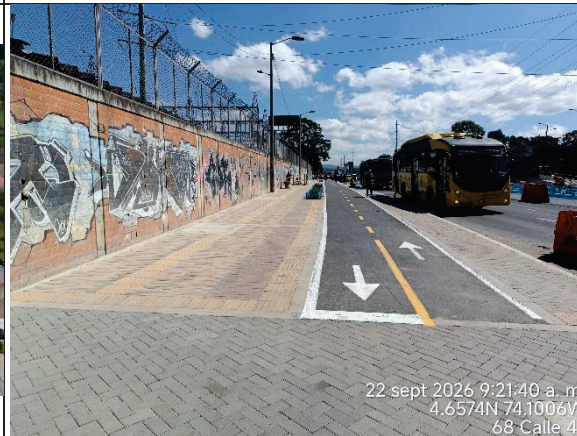
Fotografía N° 4. Finalizó la instalación de adoquín en concreto en la franja peatonal y mezcla asfáltica en la ciclorruta como parte del espacio público en el costado occidental frente a la estación BRT N°11 calle 53.
