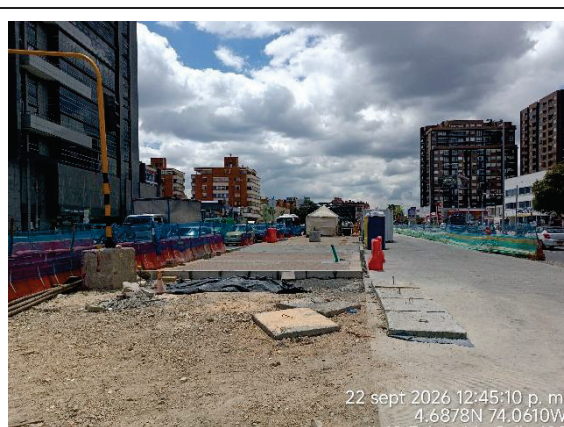
22 sept 2026 12:45:10 p. m. 4.6878N 74.0610W # 49-7 Avenida Calle 100 Fotografía N° 4. Calzada BRT vista al occidente (límite grupo 9 a carrera 53). De acuerdo con el PDT con corte al 14/09/2026, el avance en el Corredor BRT - (Límite G9 a Cr 53 (K0+850 A K1+117) es del 90.67%.
