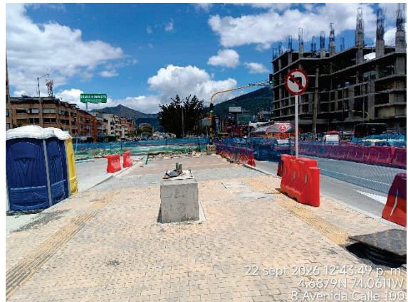
Fotografía N° 10. Se observó el avance en la instalación de adoquín en concreto en el acceso occidental de la estación BRT N°18 carrera 53.
