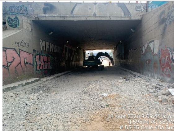
Fotografía N° 4. Se observó que ya inició la demolición de las placas de concreto existente en la intersección deprimida del sector de Venecia. De acuerdo con lo registrado en el PDT con corte al 14/09/2026, el hito “ Intersección deprimida autopista sur (reforzamiento y ampliación) - incluye demoliciones ”, tiene un avance del 30.62%.
