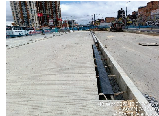
Fotografía N° 20. Avance en la fundición de concreto MR 45 para las calzadas BRT e instalación de canal prefabricado para el drenaje. De acuerdo con el Plan Detallado de Trabajo-PDT con corte al 14/09/2026, el hito "corredores BRT" presenta un avance del 67.95%.
