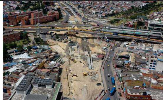
Fotografía N° 22. Se observó que se avanzó con la fundición de concreto de las estructuras de acceso a los vagones de la estación BRT N°3 (Av. Primero de Mayo). De acuerdo con el PDT con corte al 14/09/2026, el hito "estación BRT #3 – tipo específico estación Primero de Mayo" presenta un avance del 52.25%.
