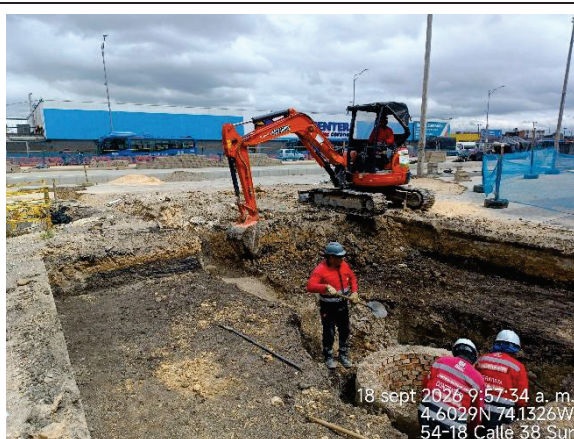
Fotografía N° 19. En el costado oriental entre las calles 37 sur y 38 sur, se observó que avanza el reemplazo de la red sanitaria.
