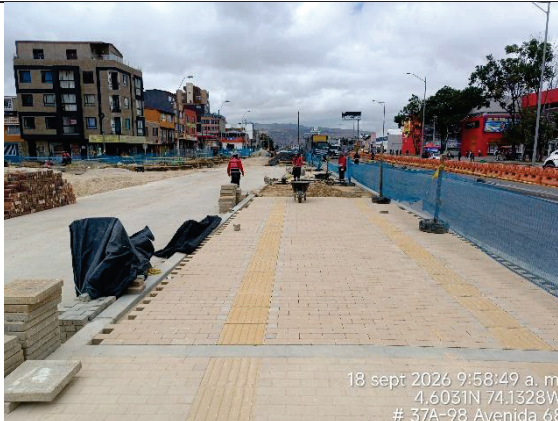
Fotografía N° 16. Estación BRT N°2 calle 40 sur. Se observó el avance de las obras de construcción del espacio público en el acceso sur a la estación con la instalación de adoquín en concreto. De acuerdo con el PDT con corte al 14/09/2026, la estación cuenta con un avance en su ejecución del 17.54%.
