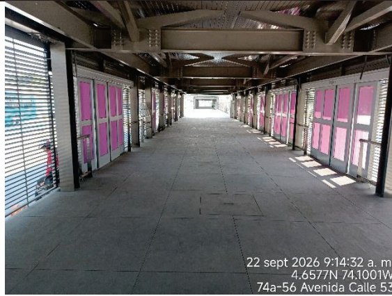
Fotografía N° 1. En la estación BRT N°11 calle 53, se concluyó la instalación de elementos de fijación para las luminarias, cieloraso y puertas de acceso. De acuerdo con el PDT con corte al 14/09/2026, se tiene un avance en la ejecución del 95.92%.
