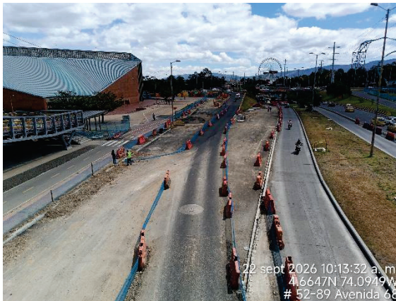
Fotografía N° 13. Panorámica hacia el norte, se avanza en la construcción de calzadas BRT y mixto costado occidental entre calles 52 y 63. De acuerdo con el PDT con corte al 14/09/2026, para el corredor mixto entre las calles 46 y 66 se tiene un avance del 89.86%.
