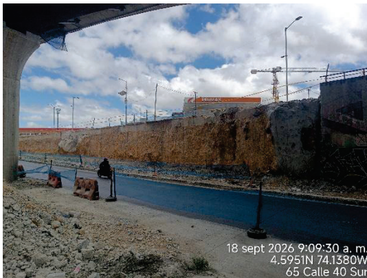
Fotografía N° 3. En la visita de campo se observó que se finalizó la fundición de los barretes, así como el remate superior del muro. De acuerdo con el PDT al corte del 14/09/2026, la actividad “ Ampliación / Muro de contención ”, tiene un avance del 100%.
