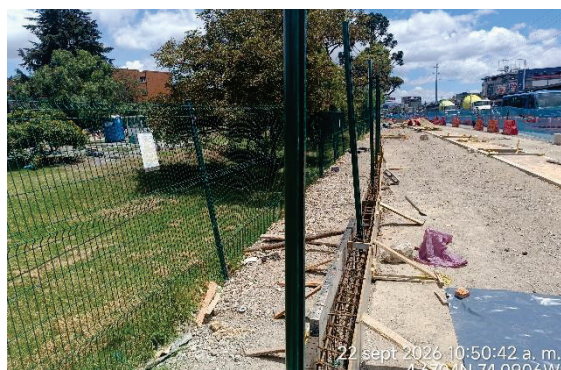
Fotografía N° 21. Frente al predio del ICBF, se inició la construcción del cerramiento de forma que el contratista pueda iniciar con la construcción del espacio público.
