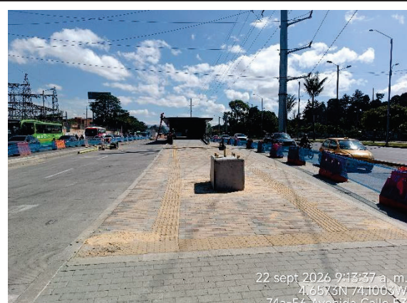
Fotografía N° 2. Avance en la construcción del espacio público en el acceso sur de la estación BRT N°11 calle 53, se observó que ya se cuenta con la base en concreto para la instalación del tótem.
