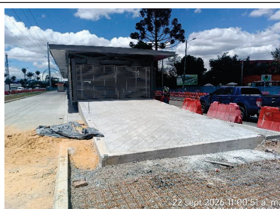
Fotografía N° 20. Avance en la fundición de concreto para las rampas de acceso norte y sur a la estación BRT N°13 Calle 66. Vista al sur en el vagón N°2. De acuerdo con el PDT, con corte al 14/09/2026, la estación tiene un avance en la ejecución del 96.20%.
