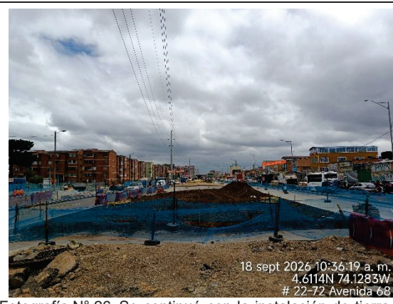
Fotografía N° 26. Se continuó con la instalación de tierra y siembra de césped para empedrización como parte de las obras de paisajismo en el separador central, entre la estación Av. Primero de mayo y el retorno operacional.
