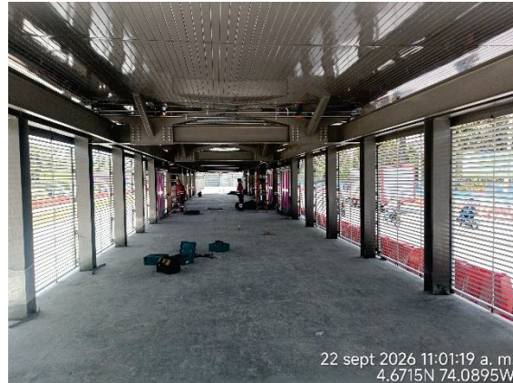
Fotografía N° 24. Se observó la instalación de concreto en la placa de piso en los vagones N°1, N°2 y pasarela central de la estación BRT N°13 Calle 66.
