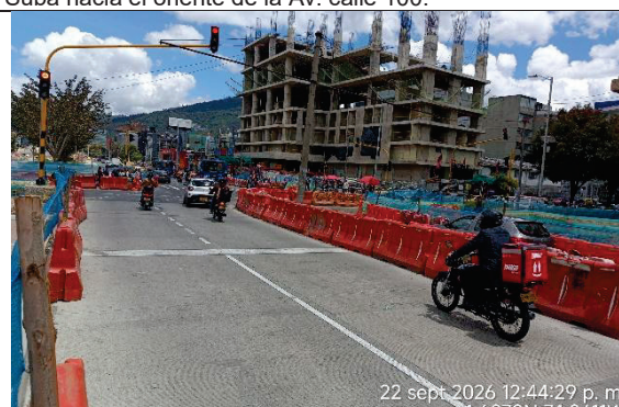
22 sept 2026 12:44:29 p. m. 4.6878N 74.0611W Fotografía N° 8. Como parte de la implementación del PMT 12, se habilitó la calzada BRT del costado sur para el paso del tráfico mixto y realizar el cerramiento de la calzada existente para iniciar su intervención. De acuerdo con el PDT con corte al 14/09/2026, el avance en el corredor BRT para el hito "sector 8 sur oriental calle 100, intersección Av. Suba hasta Carrera 47ª" es del 64.06%.
