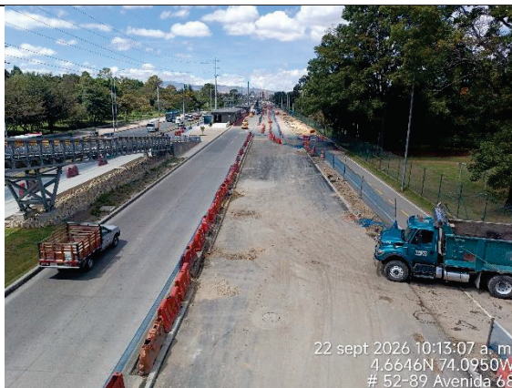
Fotografía N° 15. Panorámica hacia el sur, avance en la construcción de calzadas mixto y espacio público costado occidental entre calles 52 y 63. Se observó que se habilitó el tránsito de biciusuarios y peatones hacia el espacio público para iniciar la intervención de la calzada del tráfico mixto.
