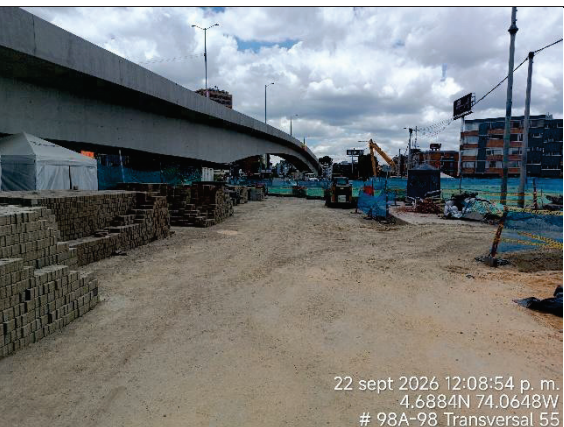
22 sept 2026 12:08:54 p. m. 4.6884N 74.0648W # 98A-98 Transversal 55 Fotografía N° 6. Se observó la instalación de concreto MR45 en el ramal que conecta el tráfico mixto de la Av. Suba hacia el oriente de la Av. calle 100.
