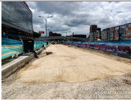
22 sept 2026 12:59:59 p.m. 4.6885N 74.0638W 54-11 Avenida Calle 100 Fotografía N° 19. Avance en la instalación de capas granulares para la conformación de la calzada de tráfico mixto en el sector 8, frente a Iserra 100.
