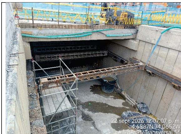
22 sept 2026 12:07:07 p. m. 4.6887N 74.0652W # 98A-96 Transversal 55 Fotografía N° 3. Se observó que continuó la excavación en espacio confinado del deprimido Av. Suba, ramal norte. De acuerdo con el PDT con corte al 14/09/2026, el avance en la ejecución del deprimido, en sus 3 ramales, es del 78.59%.
