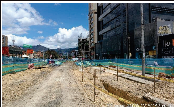
Fotografía N° 9. Se inició actividades de fresado y demolición de la carpeta asfáltica existente en la calzada del tráfico mixto entre Av. Suba hasta carrera 47A. De acuerdo con el PDT, con corte al 14/09/2026, el avance en la ejecución de la actividad "sector 8 sur oriental calle 100 (Intersección hasta Carrera 47A) / Corredor mixto" es del 7.89%.
