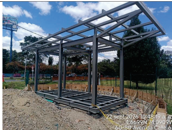
Fotografía N° 19. Avance de construcción de espacio público, costado occidental, frente al ICBF. Se observó la instalación de los ductos para red de datos y potencia en la taquilla N°6 de la Estación BRT #13 (Calle 66). De acuerdo con el PDT con corte al 14/09/2026, la taquilla tiene un avance del 87.27%.
