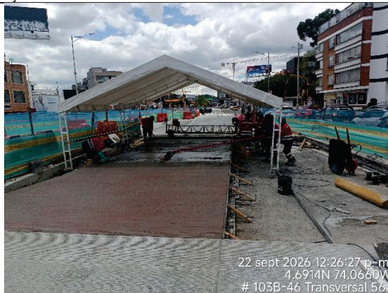
Fotografía N° 13. Se observó la instalación de concreto MR45 en el empalme norte con la calzada BRT de la troncal Av. Suba. De acuerdo con el PDT, con corte al 14/09/2026, el avance en la ejecución del hito "sector 2 nor-oriental (Av. Suba 104 hasta intersección)" continúa en 57.03%.
