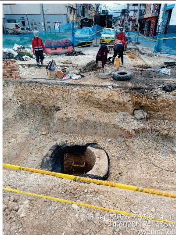
Fotografía N° 15. Se avanza con la construcción de los pozos de inspección de aguas lluvias y sanitarias así como de las conexiones de las redes que vienen de las bocacalles en el costado oriental de la troncal avenida 68.
