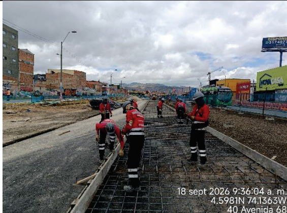
Fotografía N° 17. En el carril BRT costado oriental entre las calles 41 sur y 42 sur se observó la armada de parrillas de acero de refuerzo para instalar en las placas de concreto MR45 a fundir frente a la estación BRT.
