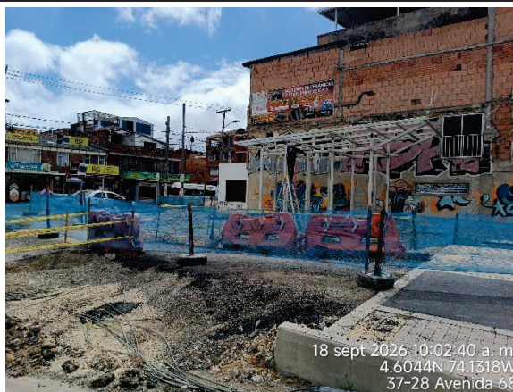
Fotografía N° 18. Se avanzó en la instalación de la estructura metálica de la taquilla oriental de la estación BRT N°2 calle 40 sur. De acuerdo con el PDT con corte al 14/09/2026, el avance general de las 4 taquillas es del 75%.
