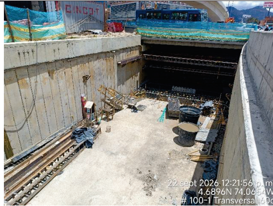
22 sept 2026 12:21:56 p.m. 4.6896N 74.0654W # 100-1 Transversal 60c Fotografía N° 15. En el ramal norte del deprimido de la Av. Suba, se avanzó con la excavación para construcción de placas de piso y sus respectivas vigas de soporte.
