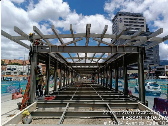
Fotografía N° 11. Inició la instalación de la estructura metálica en la estación BRT N°18 carrera 53. De acuerdo con el PDT, con corte al 14/09/2026, el avance en la ejecución de la estación es del 57.03%.
