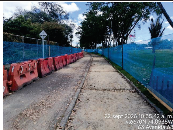
Fotografía N° 18. En el espacio público adyacente al ramal occidental de la Av. Calle 63, se realizó el cerramiento de la ciclorruta y espacio público existentes para iniciar su intervención.
