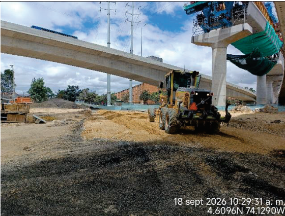
Fotografía N° 25. Vista hacia el sur, se observó que inició la instalación y compactación de las capas granulares que conforman la estructura de la calzada BRT en el sector de la conexión con estación 7 PLMB.
