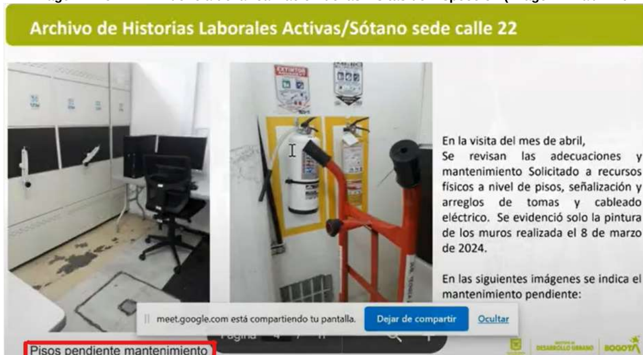
Imagen N.º 5. Evidencia de la realización de las visitas de inspección (Imagen 2 – abril 2024)
