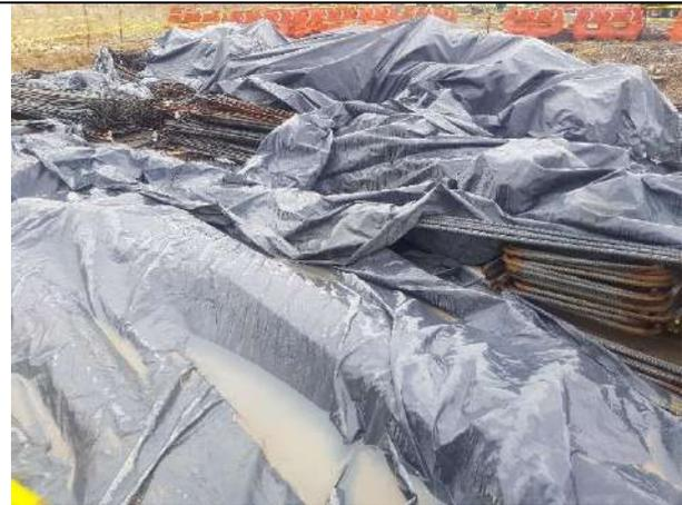
Foto 8: Almacenamiento temporal de barras de acero figurado.
