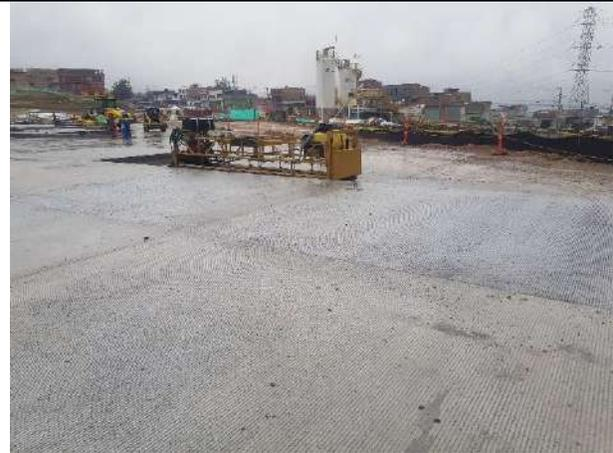
Foto 8: Construcción placa de concreto
