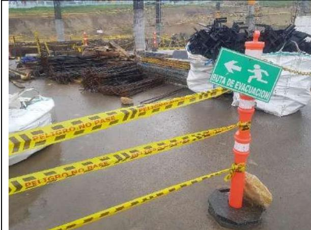
Foto 11: Almacenamiento de acero figurado expuesto
