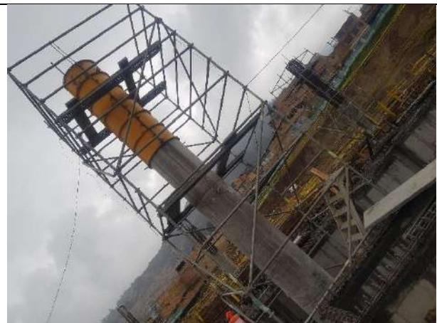
Foto 6: Izada de columnas cárcamos
