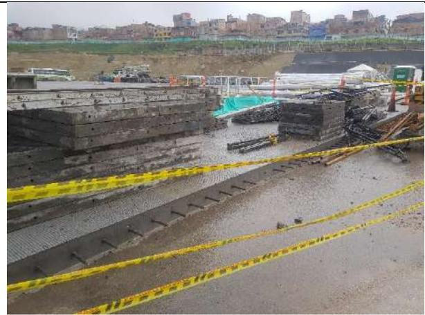
Foto 12: Formaleta y estructura metálica
