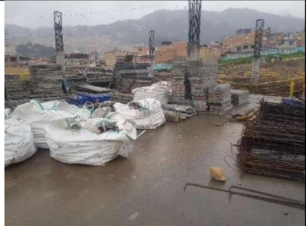
Foto 12: Almacenamiento de formaleta metálica y acero figurado expuesto.
