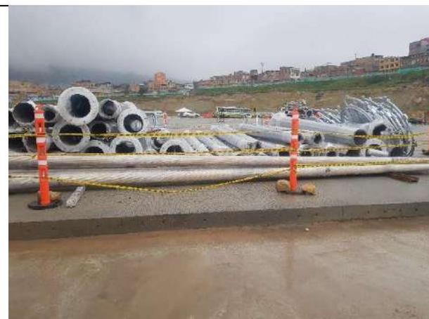
Foto 9: Almacenamiento de estructuras metálicas sin protección, aislamiento, señalización
