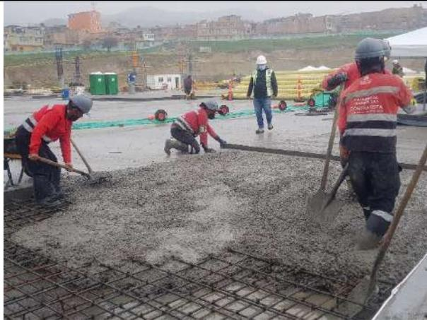
Foto 7: Construcción placa de concreto - vaciado
