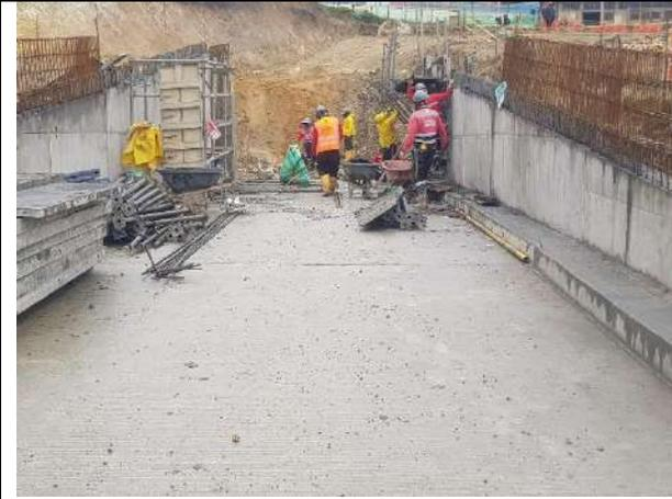
Foto 9: Módulos de losa de rodadura
