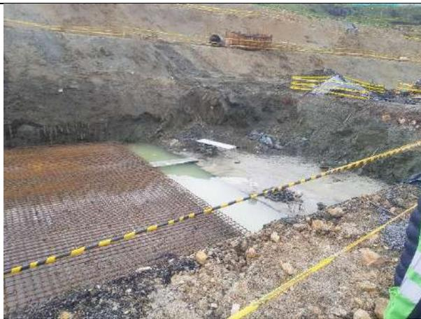
Foto 3: Inicio construcción tanque RCI
