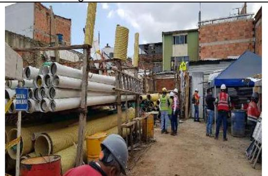
Foto 57 y 58: Área de disposición y acopio de materiales de obra
