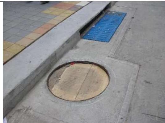
Foto 32: Falta la colocación de tapa en concreto de ESP
