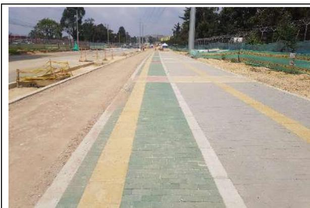
Foto 88: Instalación adoquines andenes
