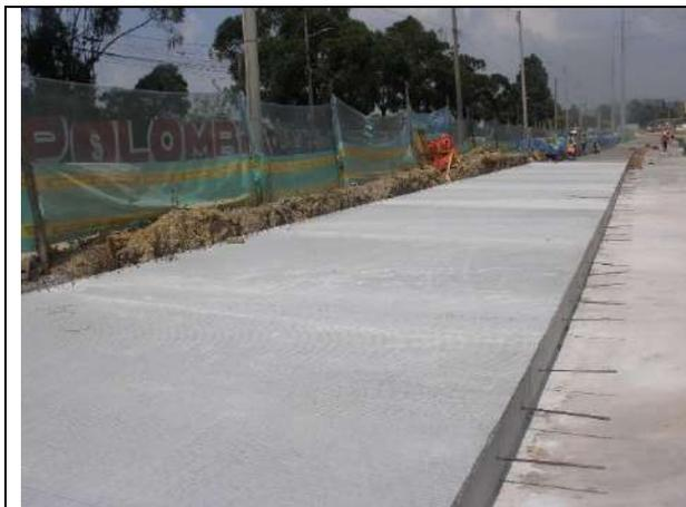
Foto 90: Construcción pavimento rígido BRT
