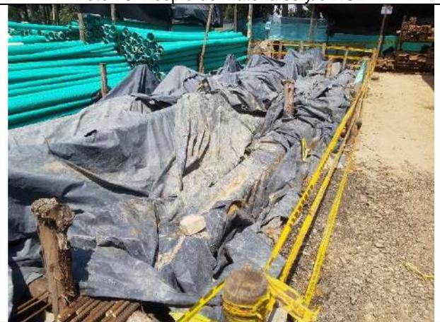
Foto 72: Acopio de materiales y/o RCD
