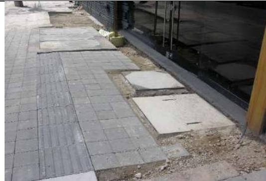
Foto 33 y 34: Finalización de acometidas de canalizaciones sobre el corredor y el remate de zona de cajas de inspección
