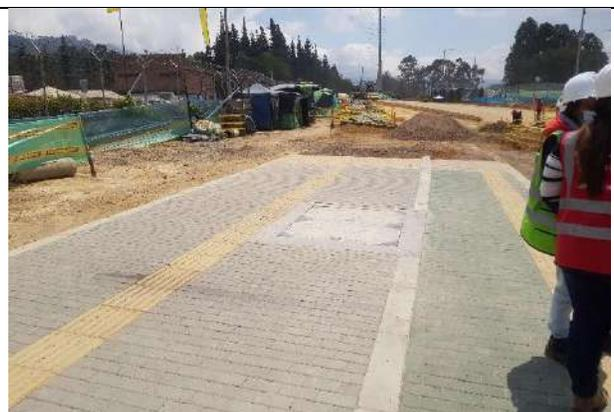
Foto 89: Instalación señales podotáctiles
