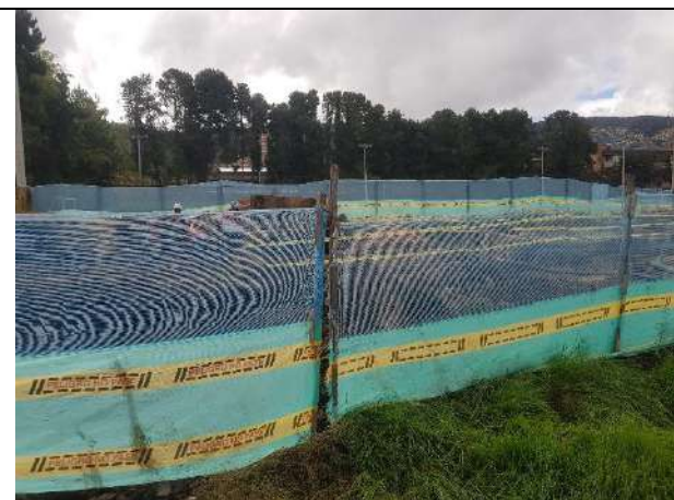
Foto 13: Cerramiento frente de trabajo 1
