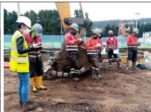
Foto 38: Capacitación con personal en obra
