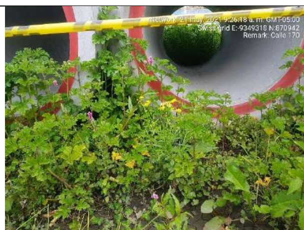
Foto 8: Acopio de materiales y/o RCD
