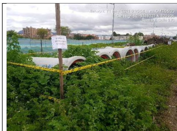
Foto 7: Acopio de materiales y/o RCD
