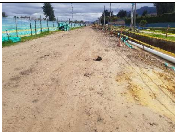
Foto 14: Cerramiento y señalización frente de trabajo 1
