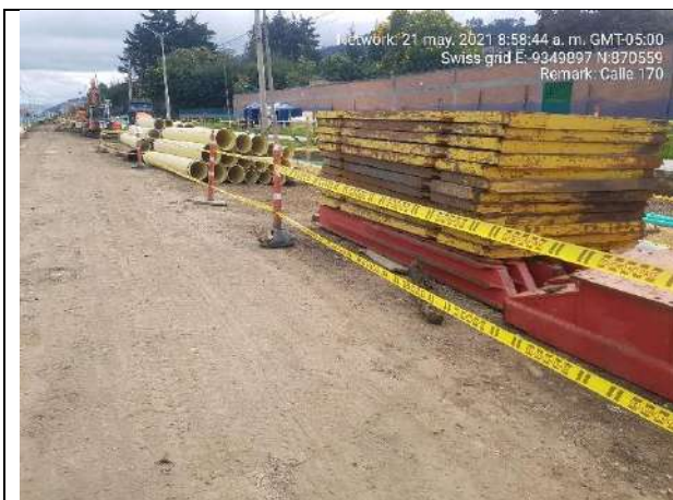
Foto 11: Almacenamiento de tubería PVC
