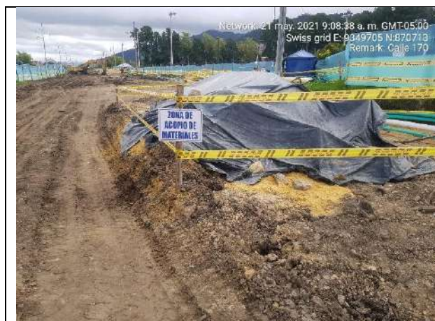
Foto 5: Cerramiento centro de acopio
