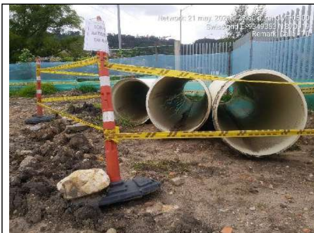
Foto 9: Almacenamiento de tubería PVC
