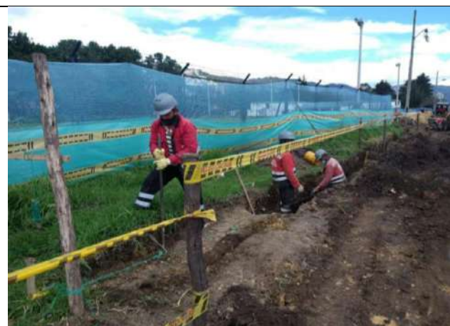
Foto 25: Personal en obra
