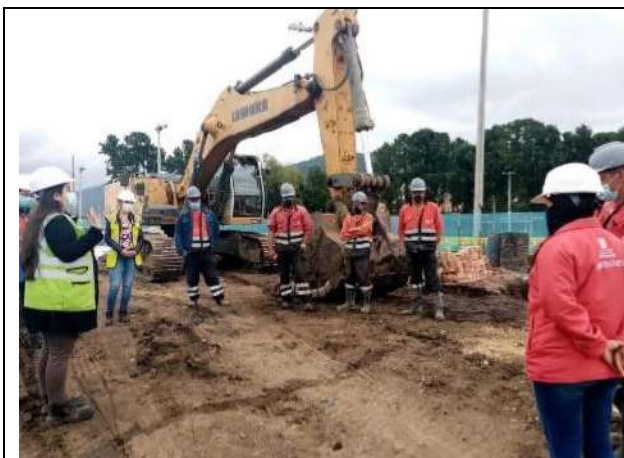
Foto 37: Capacitación con personal en obra
