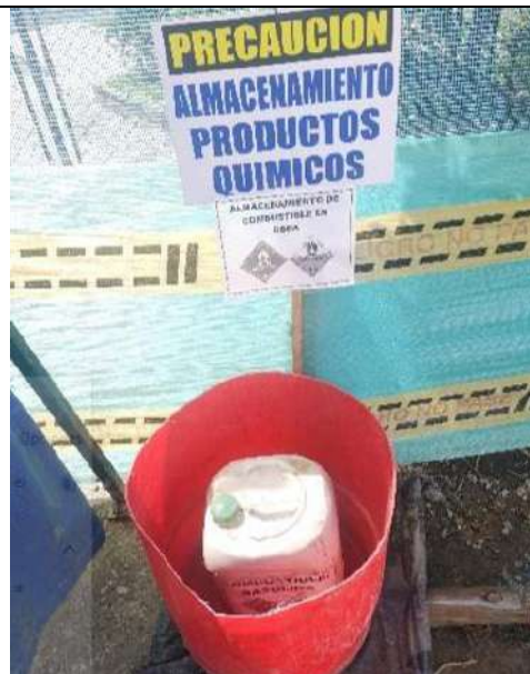
Foto 36: Punto de almacenamiento de productos químicos
