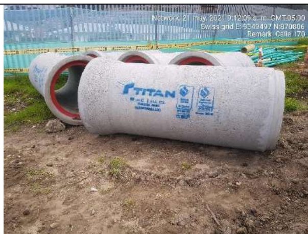
Foto 10: Almacenamiento de tubería en concreto reforzado.
