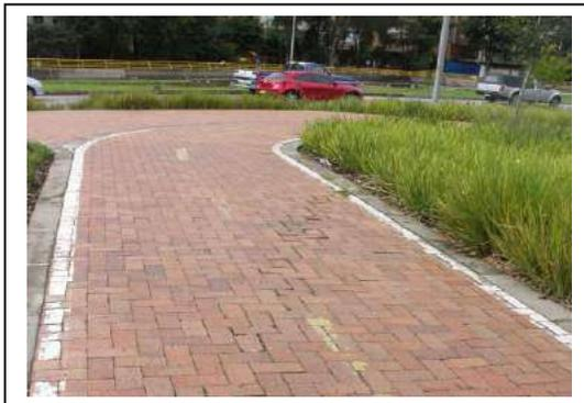
Se evidenció desconfinamiento de zona de adoquines sobre uno de los ramales, sobre el costado sur de Carrera 19; este daño fue identificado por la DTAI en la Visita de Seguimiento N°3, realizada el 18 de marzo de 2021
