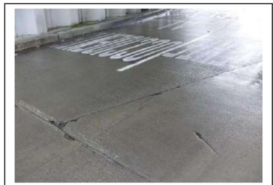
Se evidenció desportillamiento de losas de concreto sobre la calzada del ramal de Calle 94 al occidente; este daño igualmente, fue identificado por la DTAI en la Visita de Seguimiento N°3, realizada el 18 de marzo de 2021
