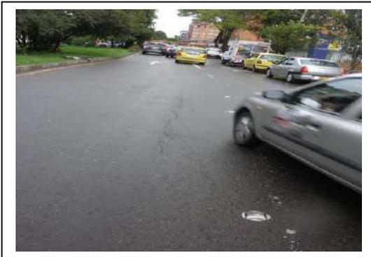
Se evidenciaron daños nuevos, correspondiente a fisuramiento longitudinal y transversal sobre la calzada norte, calzada en asfalto; este daño no fue identificado por la DTAI en la Visita de Seguimiento N°3, realizada el 18 de marzo de 2021
