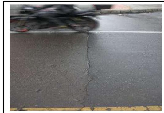
Se evidenció fisuramiento transversal en la calzada de la Calle 94 costado sur por Transversal 23, calzada en asfalto; este daño igualmente, fue identificado por la DTAI en la Visita de Seguimiento N°3, realizada el 18 de marzo de 2021
