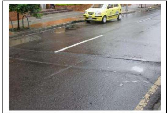
Se evidenció intervención de la calzada norte, correspondiente a canalización por parte de la EAAB; esta intervención aparentemente estaría presentando nuevos daños, correspondiente a hundimientos
