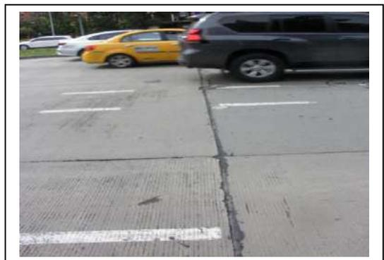
Se evidenció desportillamiento de juntas sobre losas de concreto, sobre la Av. Carrera 9, calzada norte; este daño igualmente, fue identificado por la DTAI en la Visita de Seguimiento N°3, realizada el 18 de marzo de 2021
