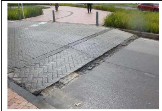
Se evidenció desportillamiento y rotura del concreto sobre la rampa vehicular, costado sur de la Diagonal 92; este daño fue identificado por la DTAI en la Visita de Seguimiento N°3, realizada el 18 de marzo de 2021
