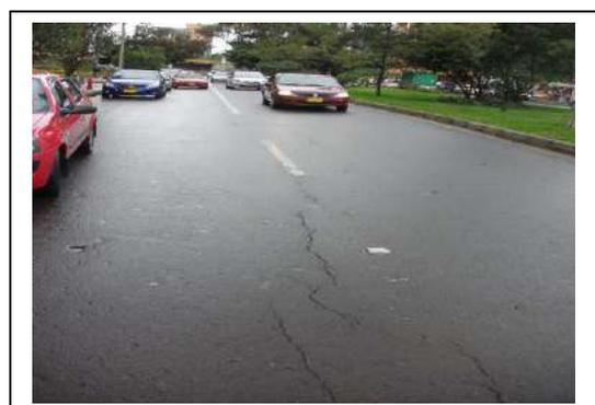
Se evidenció fisuramiento longitudinal sobre la calzada de la Calle 94 costado sur, calzada en asfalto; este daño igualmente, fue identificado por la DTAI en la Visita de Seguimiento N°3, realizada el 18 de marzo de 2021
