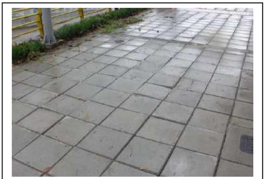
Se evidenció desconfinamiento y hundimiento de zona de adoquines prefabricados; este daño no fue identificado por la DTAI en la Visita de Seguimiento N°3, realizada el 18 de marzo de 2021
