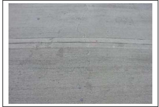
Se evidenció daño nuevo, correspondiente a fisuramiento sobre la losa del puente peatonal sobre la Carrera 9; este daño no fue identificado por la DTAI en la Visita de Seguimiento N°3, realizada el 18 de marzo de 2021
