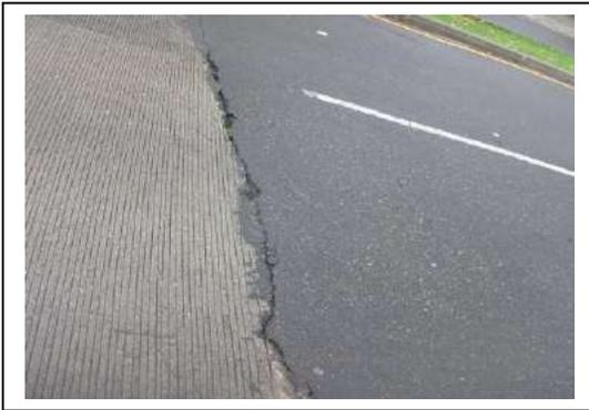
Se evidenciaron daños nuevos, correspondiente a fisuramiento transversal en la junta entre la losa de concreto y la calzada en asfalto, sobre la calzada norte de este sector (uno de los ingresos al deprimido); este daño no fue identificado por la DTAI en la Visita de Seguimiento N°3, realizada el 18 de marzo de 2021
