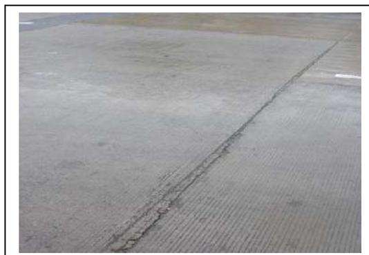
Se evidenció desportillamiento de losa de concreto sobre la calzada norte de la carrera 9; este daño igualmente, fue identificado por la DTAI en la Visita de Seguimiento N°3, realizada el 18 de marzo de 2021
