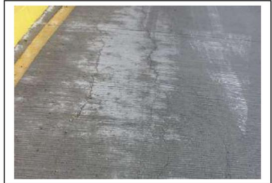
Se evidenció daño nuevo, correspondiente al fisuramiento de losas de concreto sobre la glorieta del deprimido de la Calle 94, costado Oriental; este daño no fue identificado por la DTAI en la Visita de Seguimiento N°3, realizada el 18 de marzo de 2021
