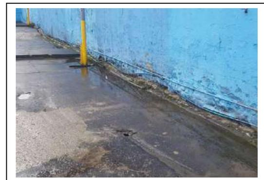
El parqueadero se encuentra ubicado en CR 12 N° 84 -42, Durante la visita se pudo observar que, el cerramiento metálico tiene partes oxidadas, además se encuentra desprendido en la esquina sur occidental, el patio de estacionamiento en asfalto presenta baches y agrietamientos, la demarcación se encuentra en regular estado, hay tubería de redes secas expuesta, es personal que trabaja en el parqueadero tiene los elementos de bioseguridad, los baños y caseta se encuentran en buen estado.
