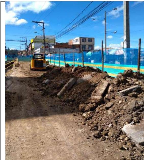
**Foto No. 1** Acopio de materiales, sin identificación y superando tiempos de almacenamiento.
