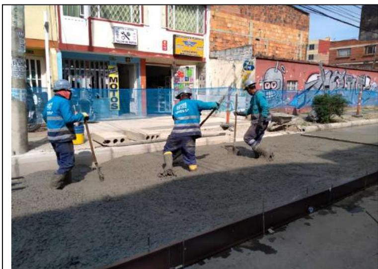
**Foto No. 6.** Cuadrilla sin utilizar gafas de protección, actividad de vaciado de concreto.
