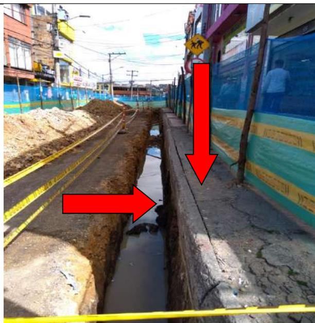
**Foto N.º 19.** Socavación de terreno y afectación de sardinel.
