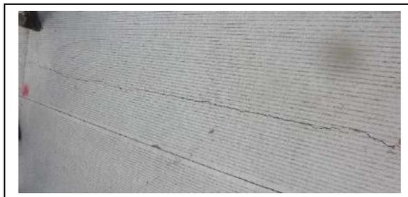
Algunos elementos de las losas con fisuras los cuales Fueron por identificación y trazabilidad incluidos en un instrumento gráfico que la interventoría mantiene para evidenciar estos elementos que no cumplen las calidades
