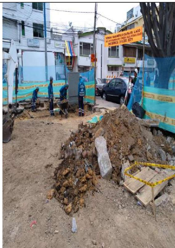
**Foto No. 4** Material de excavación, acopio inadecuado.
