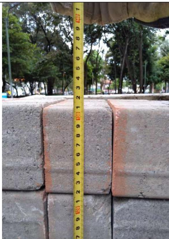
**Foto No. 1** Acopio de material prefabricado superando el límite de altura.
