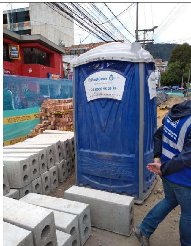
**Foto No. 2** Acopio de material prefabricado sin señalizar
