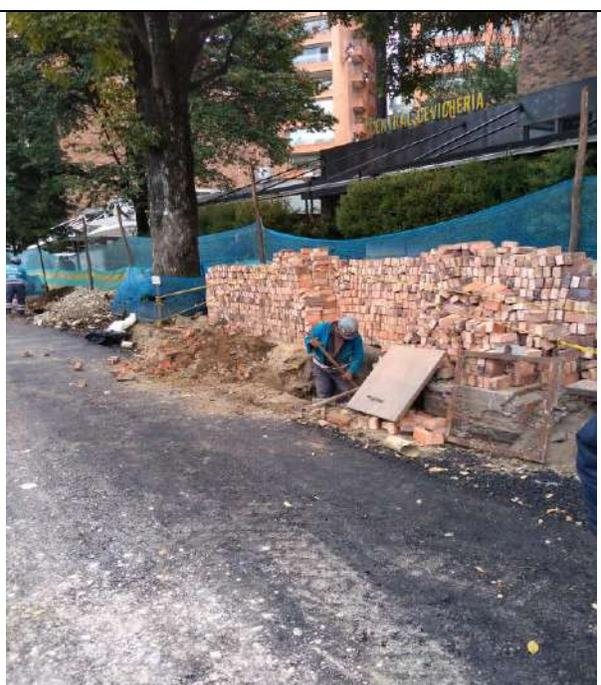
Foto No. 11 Acopio de material inadecuado.
