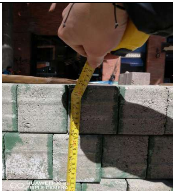
Foto No. 2 Acopio de material prefabricado cumpliendo con el límite de altura
