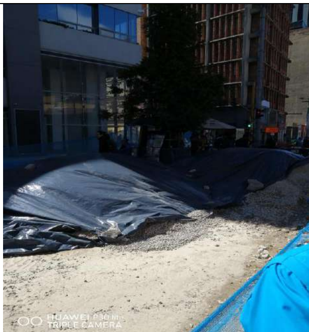
Foto No. 4 centro de acopio material pétreo.
