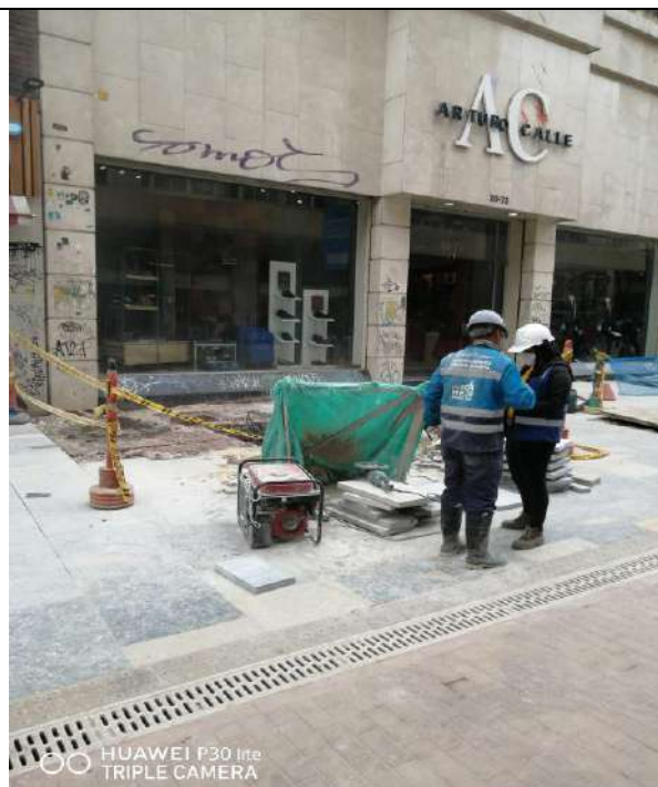
Foto No. 8 Cortes generados fuera del área correspondiente.
