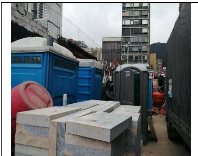
Foto No. 7 instalación de unidades sanitarias (baño).
