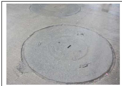
Se observa pozo de inspección sin sello ubicado en la carrera 12G N°40B-01
