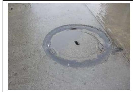
Se observa hundimiento de pozo de inspección, frente a la placa 16-21 (antigua nomenclatura). Igualmente, se observa fisura sobre losa de concreto, frente a la placa 13B-17. Así, mismo, se observa hundimiento de tapa de pozo en la Transversal 16 por diagonal 46 sur (nomenclatura antigua).
