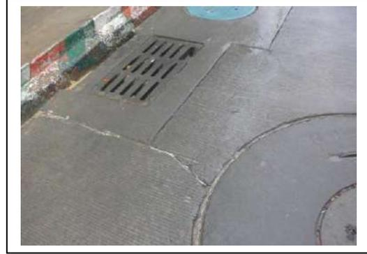
Se observa despotillamiento de losa en concreto, frente a la placa 40B-06, la cual había sido reparada por el contratista; así mismo, se observa fisura inducida en la losa, adyacente al pozo de inspección frente a la placa 12G-59.
