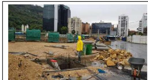
Durante el recorrido se pudo apreciar la construcción de un muro de contención en el marco del plan parcial que es tangencial a la zona de sesión. Igualmente el urbanizador se encontraba construyendo instalaciones para las redes de servicios.
