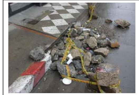
Se observa losa en concreto desportillada, frente a la placa 13J-38; así mismo, se observa rotura de losa la cual aparentemente fue intervenida por la EAB, frente a la placa 13H-45; se evidencia grandes acopios de material de demolición, lo que se traduce en desorden y riesgos para transeúntes y circulación de vehículos por el sector.
