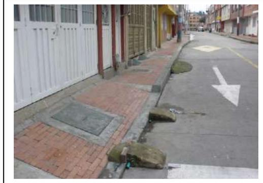
Se observa tramo de vía y andenes en buen estado hasta la carrera 98; sin embargo, en la esquina del costado norte se evidencia aposamiento lo que podría generar riesgo en la estabilidad de la calzada en concreto. Para el tramo desde la calle 96A hasta la Calle 97, se evidenció intervención de terceros conocidos, frente a las placas 94A-27, 96A-92 y 96A-94, ya que se han construido rampas de acceso vehiculares en estos sectores sin tener la autorización para su intervención.
