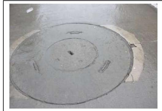
Se observa falta de sello alrededor de pozo de inspección, frente a la placa 12-6; así mismo, se observa desportillamiento de zona reparada adyacente al pozo de inspección, frente a la placa 12D-19.
