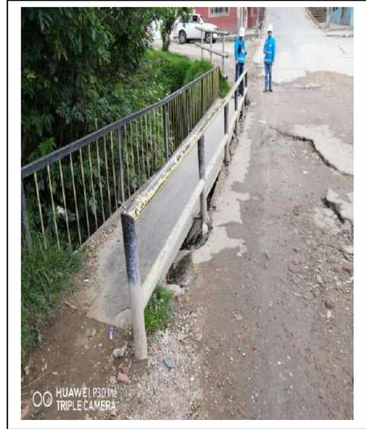
Este puente vehicular se encuentra en condiciones muy desgastantes, como se puede observar en el registro fotográfico, cuenta con acceso peatonal y vehicular, ambos elementos están con desgastes en cada uno de sus componentes, la inspección visual, solo se logró realizar superficialmente, debido al difícil acceso que no se pudo tener, para observar el estado actual de la cimentación.
