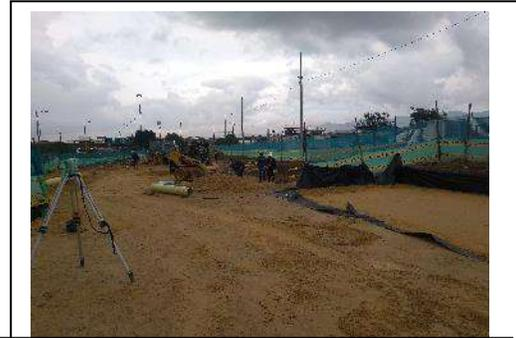
En el recorrido se pudo observar las labores de compactación de la base, y la construcción de pozos de alcantarillado.
