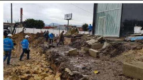
Se pudo apreciar la excavación y los materiales de la base. La DTAI realiza acompañamiento para la nivelación de topografía
