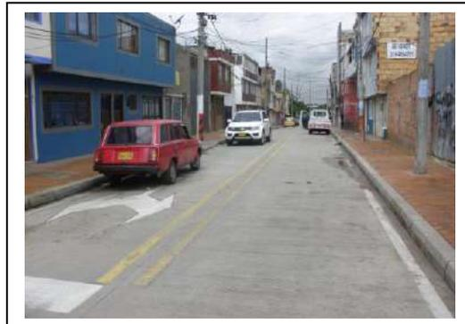
Se observa obra correspondiente a intervención de vía y andenes en buen estado; sin embargo, se observó intervención de una de las losas de concreto (intervención de un tercero desconocido, frente a la placa 127B-75), la cual presenta diferente textura y acabados, lo que podría generar problemas de estabilidad en este tramo de vía más adelante.
