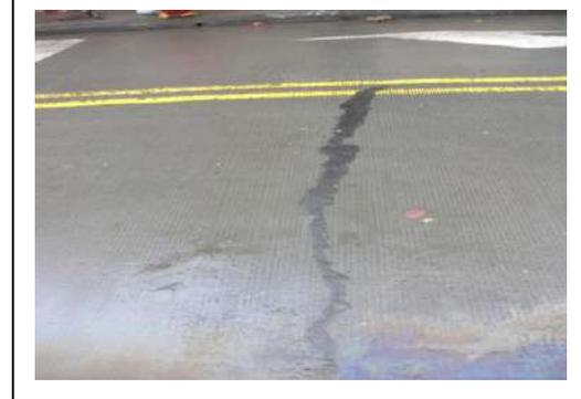
Se observa despotillamiento de área adyacente a pozo de inspección que había sido reparada por el contratista frente a la placa 41-09; igualmente, se observa fisura inducida en losa de concreto frente a la placa 42-47. Así mismo, se observa sello de fisura reparada por el contratista, frente a la placa 42-81.
