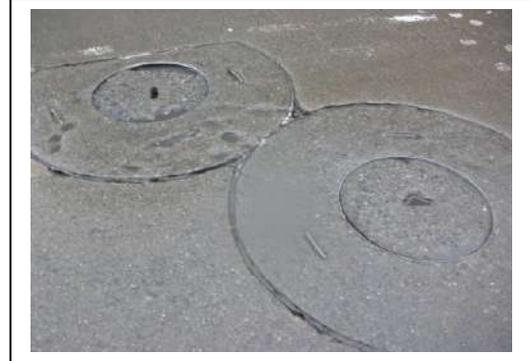
Se observa daño sobre losa de concreto, producto de una intervención frente a la placa 13H-16; así mismo, se observa una fisura incipiente alrededor del pozo de inspección, frente a la placa 16-21 (nomenclatura antigua).
