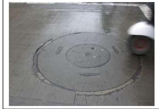
Se observa fisura en la losa de concreto adyacente al pozo de inspección ubicado frente a la placa 13-18. Igualmente, se observa pozo reparado por el contratista, el cual presenta desportillamiento alrededor del pozo de inspección; se requiere requerir nuevamente al contratista a fin de reparar los nuevos daños evidenciados.
