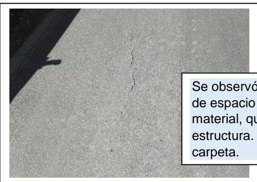
Se observó deterioro de superficie de espacio público, con pérdida de material, que pueden afectar la estructura. Así como fisuras en la carpeta.
