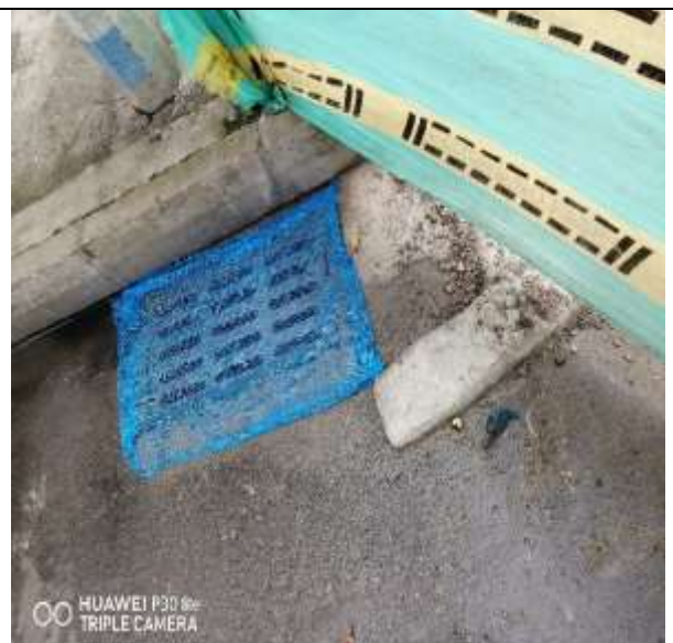
Foto No. 6 Protección de sumideros.
