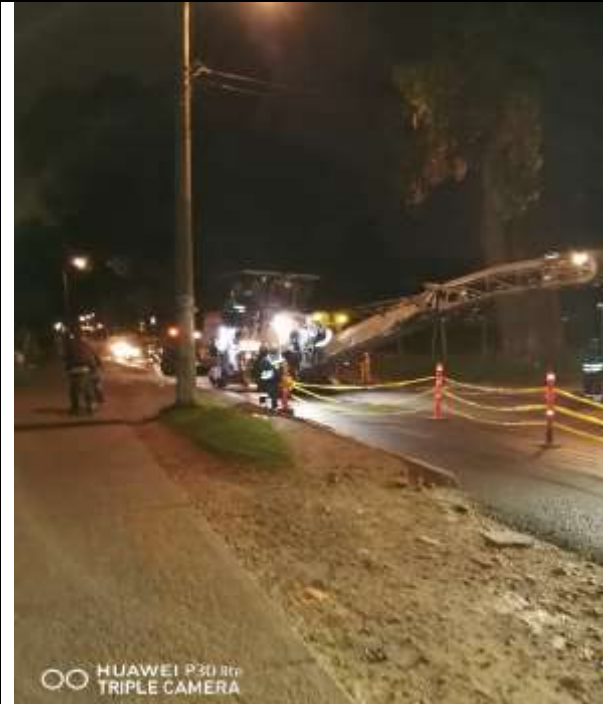
Foto No. 8 Fresadora llegando al frente de obra.
