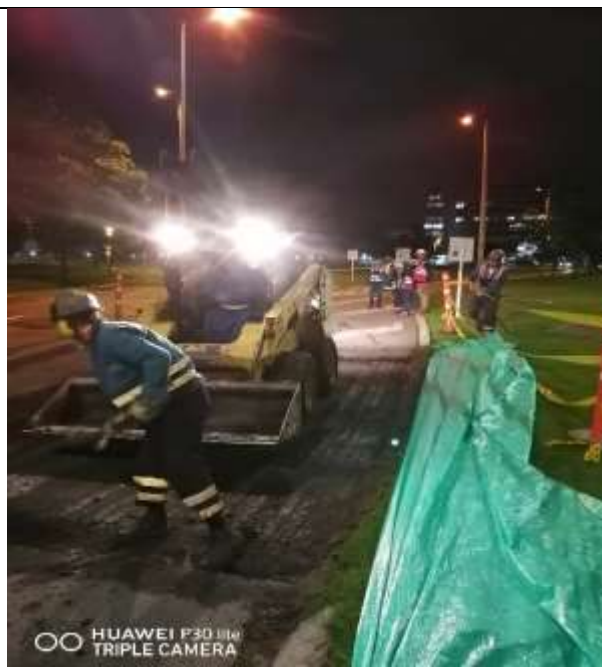
Foto N.º 22. Frente de obra nocturno.
