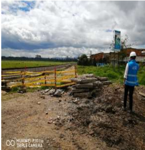
Foto No. 1 Material RCD acopiado fuera del área delimitada.
