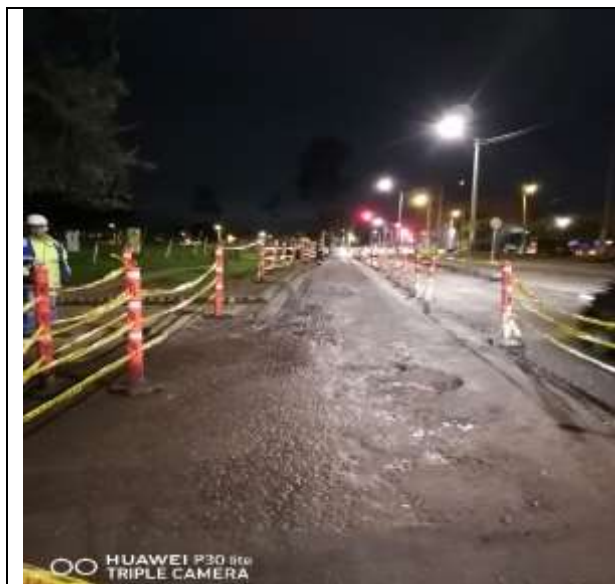
Foto No. 5 Adecuado manejo de cerramiento.
