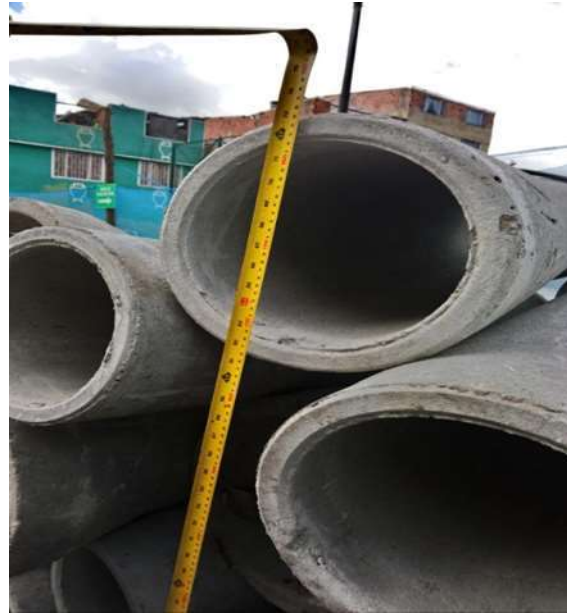
Foto No. 2 Altura de acopio: 1.85 m.
