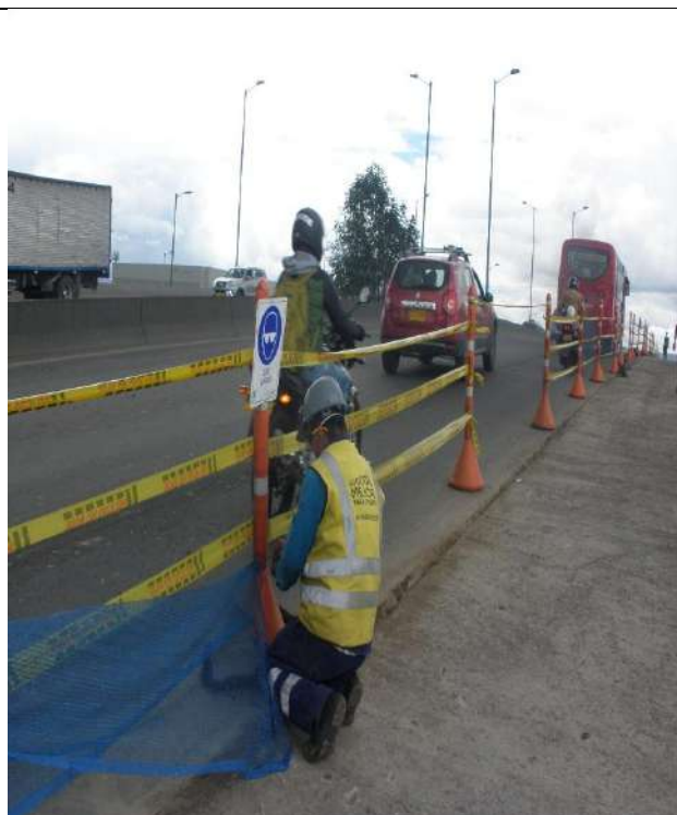
Foto N.º 13. Puente N.º 14 Av. Ciudad de Cali por Av. Jorge Eliécer Gaitán (costado oriental).
