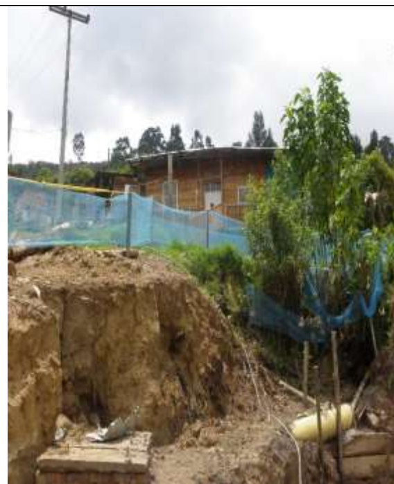
Foto No. 18. Muro en gavión sin actividad de intervención.
