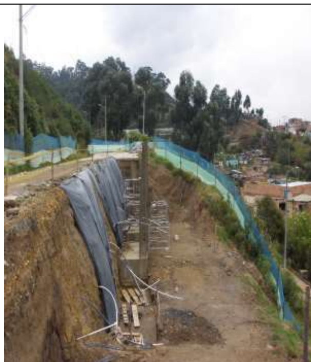
Foto No. 17. Muro 3 sin actividad de intervención.
