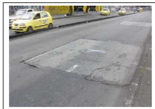
Se observa áreas correspondientes a losas de concreto sobre el carril de Transmilenio, las cuales fueron reemplazadas por mezcla asfáltica; así mismo, se evidencian identificación de losas por parte del contratista e interventoría, que requieren ser intervenidas a través de este contrato, ya que están afectando la movilidad del sector (costado occidental)
