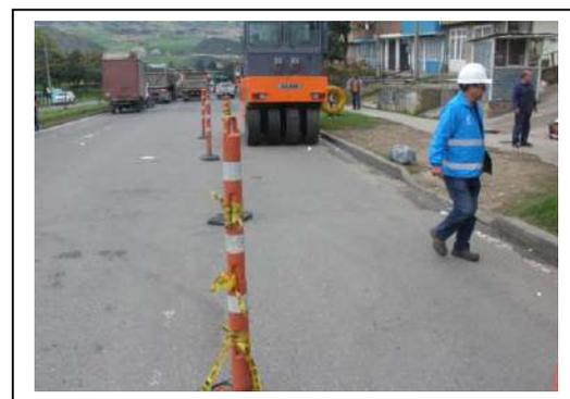
Se observa intervención de la Av. Al Llano, consistente en fresado de capa asfáltica y limpieza de sumideros; sin embargo, se observan sumideros colmatados y deficiencias en el cerramiento; se no se cuenta con adecuadas áreas de delimitación y paso para peatones (costado sur-oriental)
