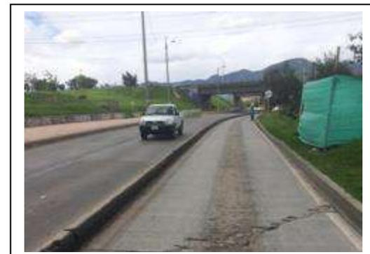
Se observan áreas intervenidas en horario nocturno, correspondientes a calzadas mixtas que fueron reparadas con mezcla asfáltica, la cual presenta adecuados acabados; así mismo, se evidencian losas de concreto correspondientes al carril Transmilenio, las cuales presentan fracturamiento, fisuramiento, pérdida de material y escalonamiento, las cuales deben ser reparadas para una adecuada operación del sistema, frente al patio del sistema Transmicable.
