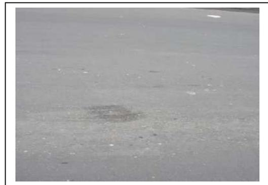
Se observa intervención de la Av. Al Llano, consistente en fresado de capa asfáltica y limpieza de sumideros; sin embargo, se observa mezcla asfáltica colocada, la cual presenta deficiencias de textura y acabado en algunos tramos (costado sur-occidental)
