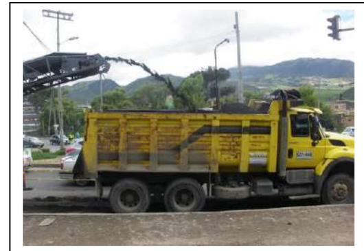
Se observa intervención de la Av. Al Llano, consistente en fresado de capa asfáltica y limpieza de sumideros. Se observa corredor a ser intervenido, el cual carece de una adecuada delimitación del área de trabajo. Se evidenció actividades de fresado de la capa asfáltica existente; así mismo, se observa personal de obra haciendo uso adecuado de los elementos de protección personal (costado sur-oriental)
