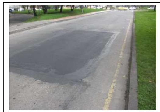
Se observan áreas intervenidas en horario nocturno correspondientes a la colocación de carpeta asfáltica en el sector; se evidencian adecuados procesos constructivos en la instalación de la mezcla asfáltica
