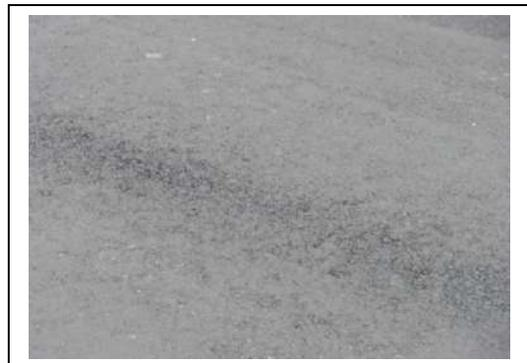
Se observa corredor intervenido a través del fresado de la capa asfáltica, la cual presenta deficiencias de acabado en alguno de los sectores frente al parque el Tunal; así mismo, se evidencia fracturamiento y escalonamiento de losa de concreto sobre el carril Transmilenio, la cual requiere ser intervenida.
