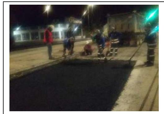
En la visita nocturna al frente de obra, se observó la implementación del PMT, así como lo correspondiente al MAO (Manejo Ambiental en Obra). Igualmente, en la jornada se realizaron los trabajos de aplicación de la mezcla asfáltica y lo cual se comprobó en una nueva visita para verificar el estado de acabado final. No obstante, se pudo observar que el material de demolición de las losas de concreto no fue protegido al final de la jornada.
