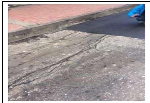
Se observa área intervenida la cual evidencia la colocación de la capa asfáltica en horario nocturno; se observó perímetro del área intervenida con exceso de asfalto líquido, lo que podría traducirse en una mezcla saturada y que no ha sido curada; así mismo, se pudo evidenciar otros tramos más deteriorados que no han sido intervenidos.
