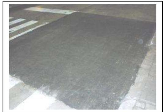
Se observa la logística implementada por el contratista en el tramo a ser intervenido; así mismo, se evidenció proceso de demolición de losas de concreto, material que será dispuesto en los sitios autorizados. Igualmente, se evidenció tramos reparados con mezcla asfáltica, los cuales presentan adecuados acabados; sin embargo, se evidenció que extintores, botiquines y camillas no están cumpliendo con la normatividad Colombiana para ubicación y uso (costado sur-occidental)
