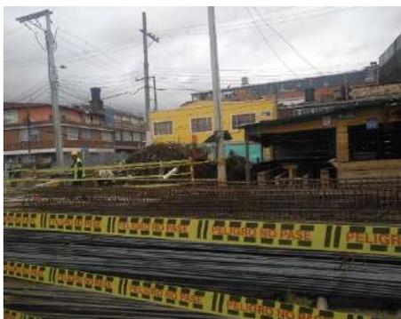
Imagen N° 17. Acopio de material de RCD una altura superior a 1.50m
