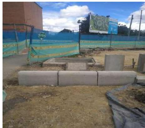
Imagen N°. 31 y 32 Sitios de excavación sin aislamiento ni señalización
