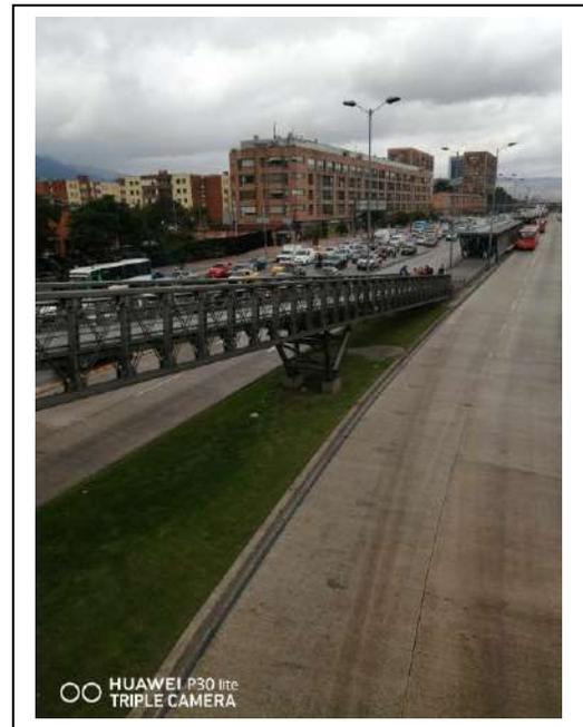
En el recorrido desarrollado para este puente, se observa, que se mantiene en sus condiciones de entrega, exceptuando por la rampa de acceso del costado oriental, la cual se observa con marcas de grafitis, al igual que en los apoyos de este costado.
