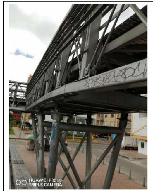
En el recorrido desarrollado para este puente, se observa, que los apoyos del costado oriental, se encuentra con marcas de grafitis, al igual que las barandas superiores del puente, las secciones donde circulan los peatones se encuentra en óptimas condiciones.
