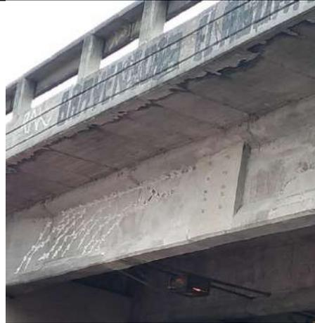
Con la finalidad de que en el reemplazo de la carpeta asfáltica no se reflejen las fisuras y grietas consecuencia de sobrecargas y no se trasladen a la capa de rodadura, el contratista realiza los sellos de las fisuras y grietas con productos sika.
