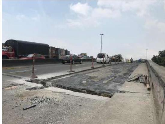
Inician intervenciones en puente, donde realizan trabajos simultáneos de sello de fisuras, demolición de carpeta asfáltica deteriorada y reemplazo de juntas de expansión.
