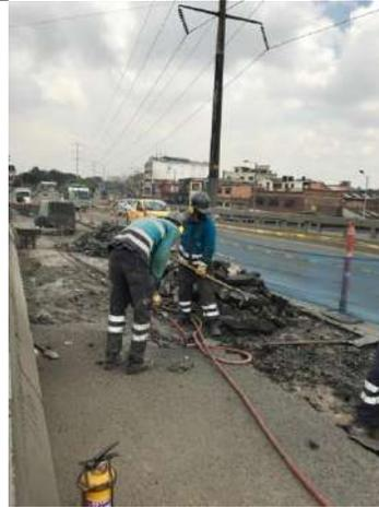
Se están realizando labores de reemplazo de la carpeta asfáltica, y no se han podido intervenir simultáneamente más de un tramo.
