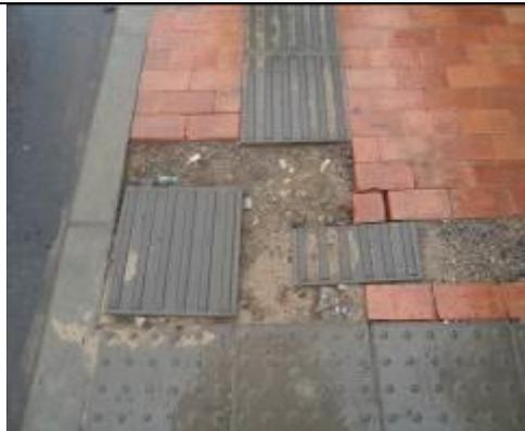
Foto 8. Tomada Calle 165 entre Cra 9 y Cra 7, donde se evidencia la deficiencia el deterioro del
