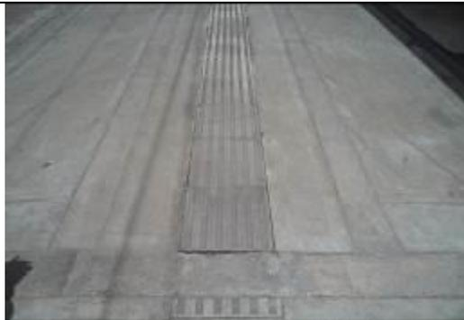
Foto 5. Tomada Carrera 32 entre calles 10 a 19, donde se evidencia malos acabados en las juntas de dilatación de las losetas.
