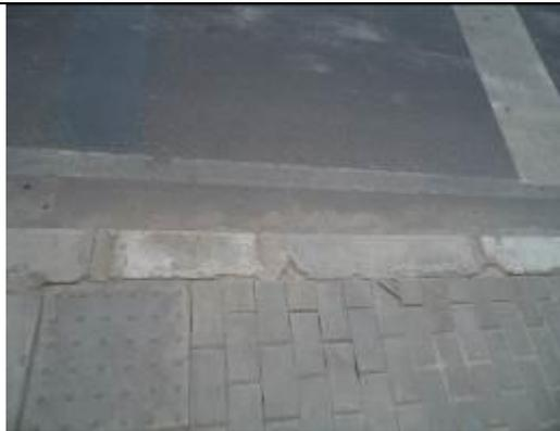
Foto 7. Tomada Calle 75 entre Cra 96 y Cra 91A, donde se evidencia la deficiencia de los remates en
