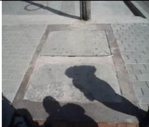
Foto 4. Tomada Calle 8 sur entre Cra 50 y Cra 31A, donde se evidencia los deficientes acabos y terminados alrededor cajas inspección y frente a las manijas
