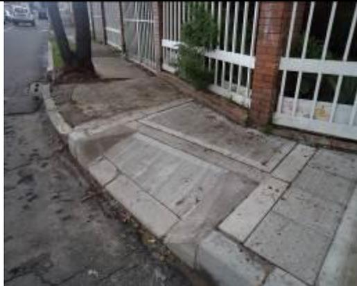
Foto 2. Tomada Cra 53 entre calle 104B y 116, donde se evidencia los deficientes acabos y terminados del vado de acceso peatonal y los bordillos.
