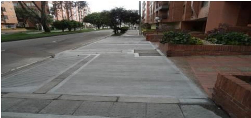
En la fotografía se observa andén construido en concreto con algunas losas, se evidencia que el andén se encuentra a nivel y garantiza la circulación peatonal
