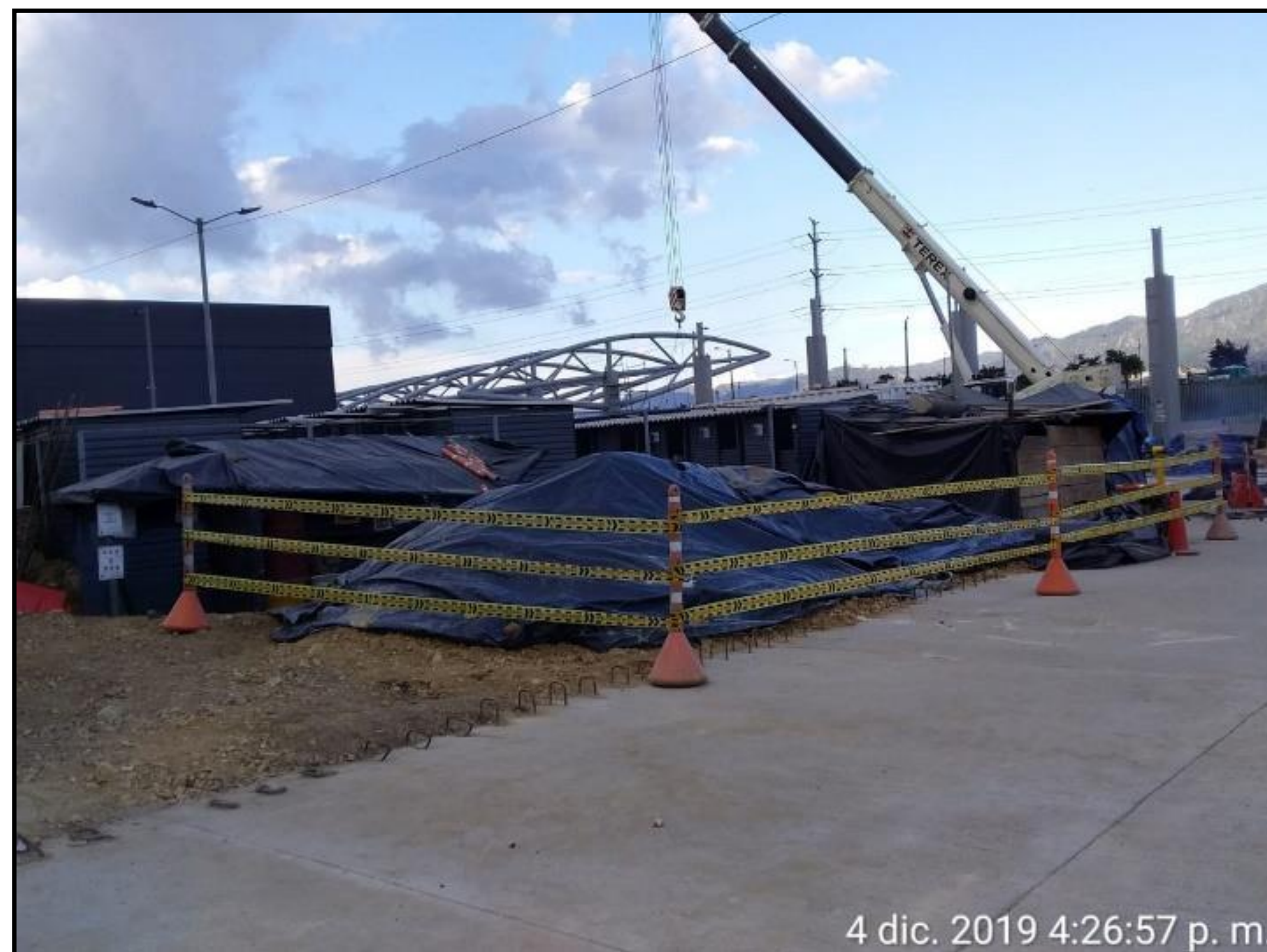
ACOPIO DE MATERIALES GRANULARES
