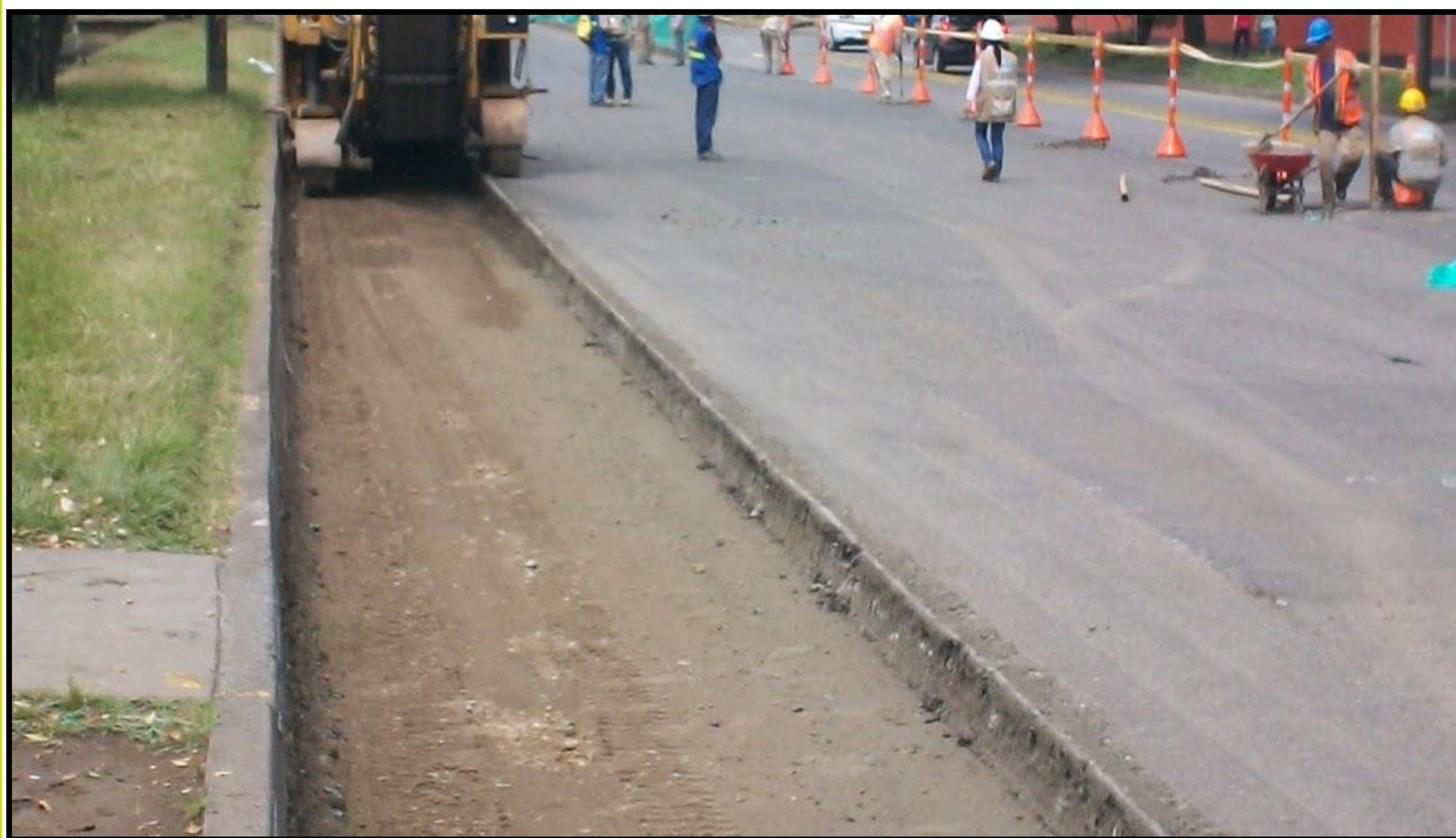
Demolición de Pavimento Asfáltico
