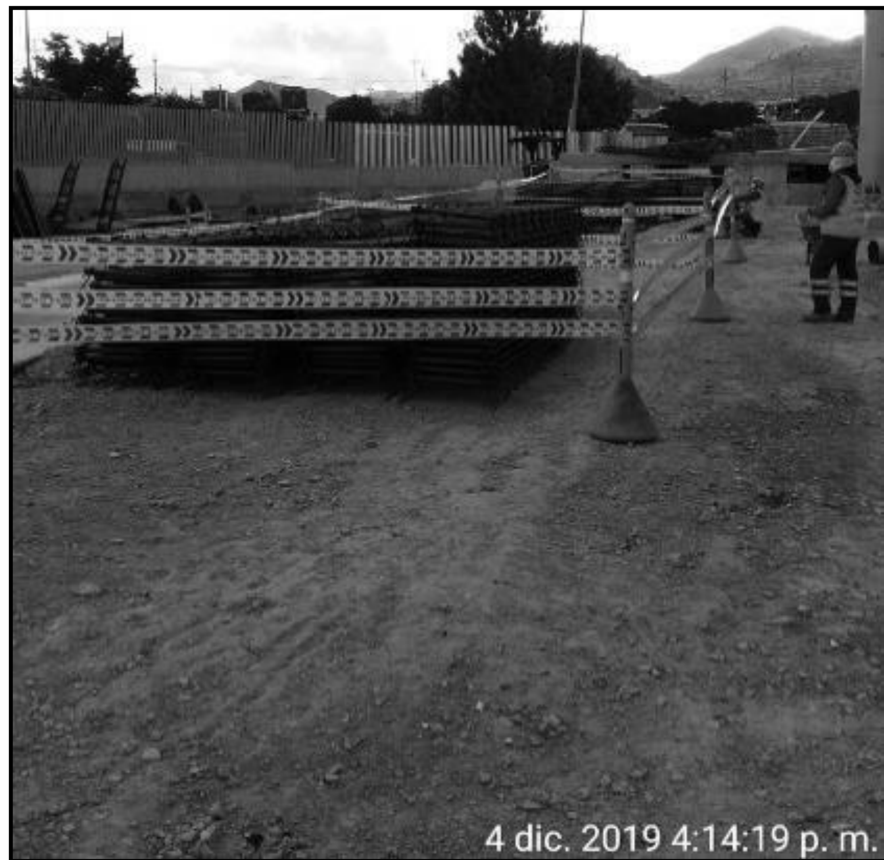
ACOPIO DE MATERIALES PREFABRICADOS
