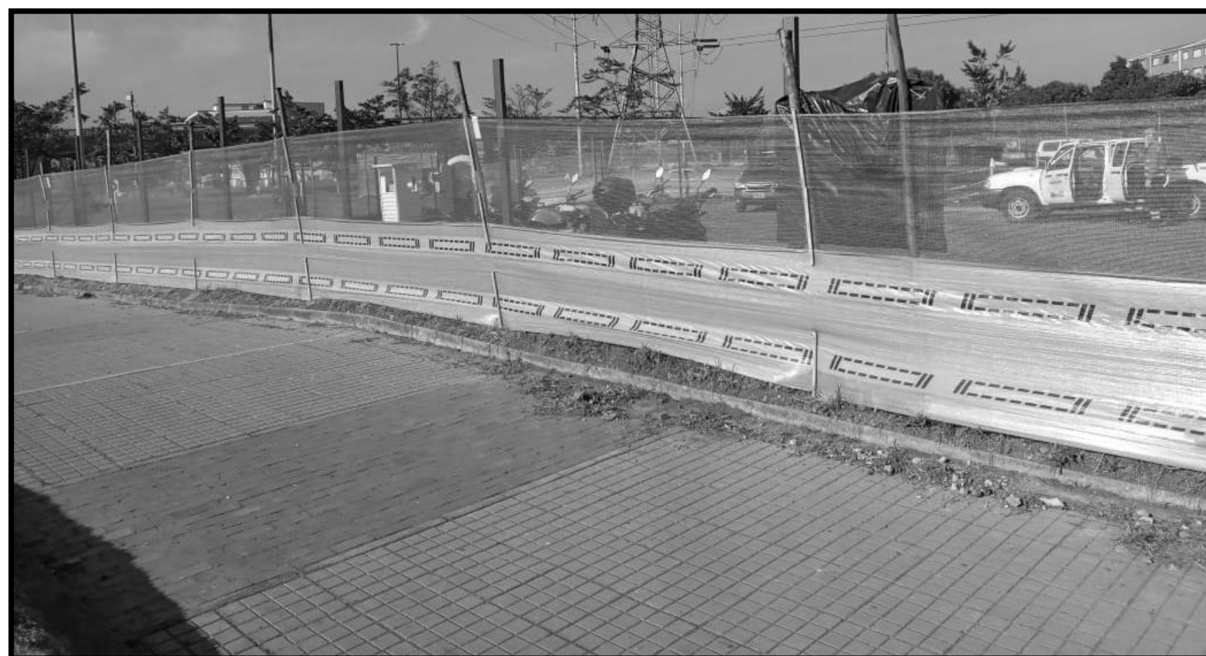
CERRAMIENTO DE OBRA
