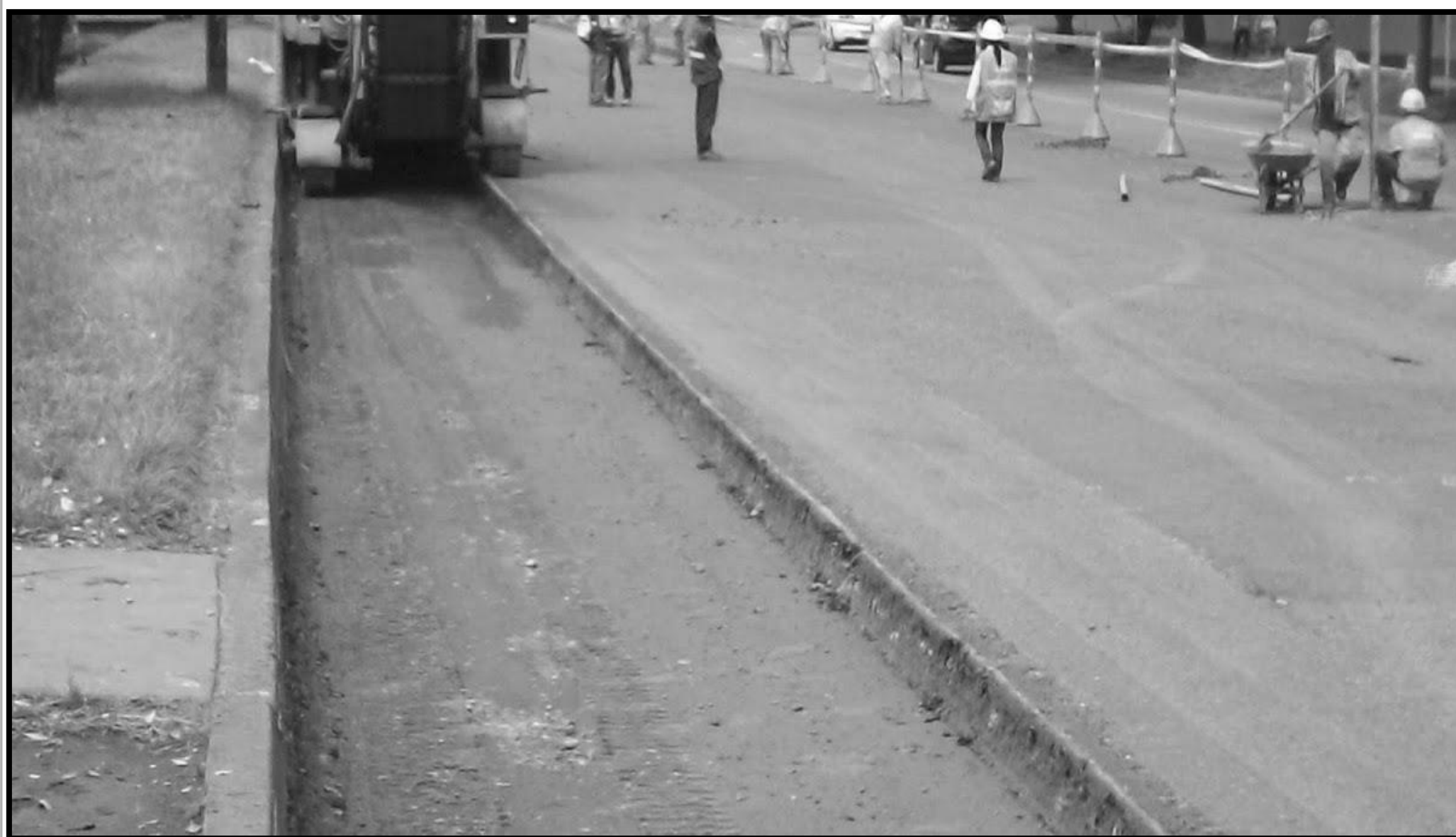
Demolición de Pavimento Asfáltico
