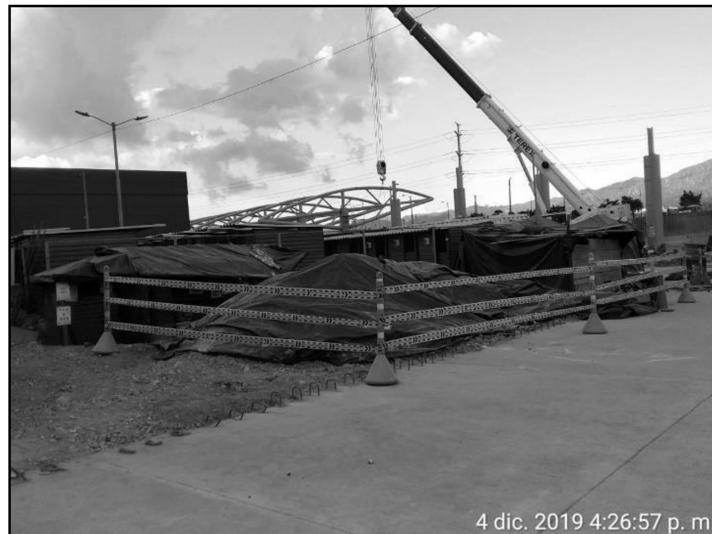
ACOPIO DE MATERIALES GRANULARES
