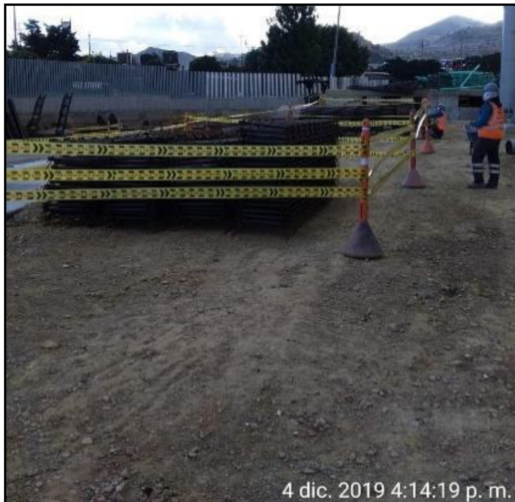
ACOPIO DE MATERIALES PREFABRICADOS
