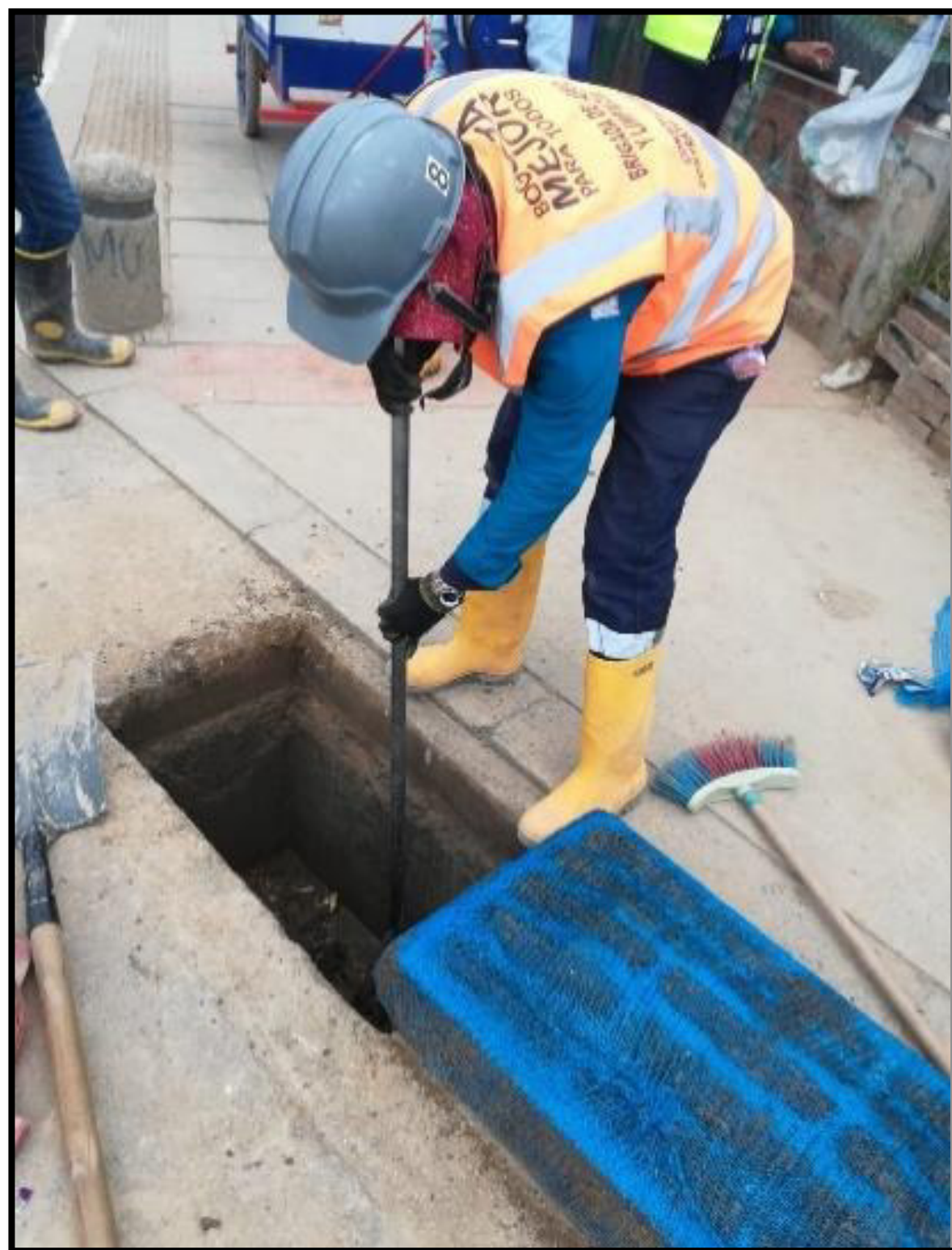
LIMPIEZA DE SUMIDEROS
