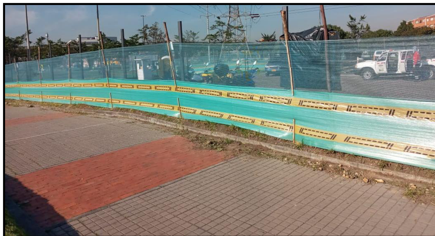
CERRAMIENTO DE OBRA
