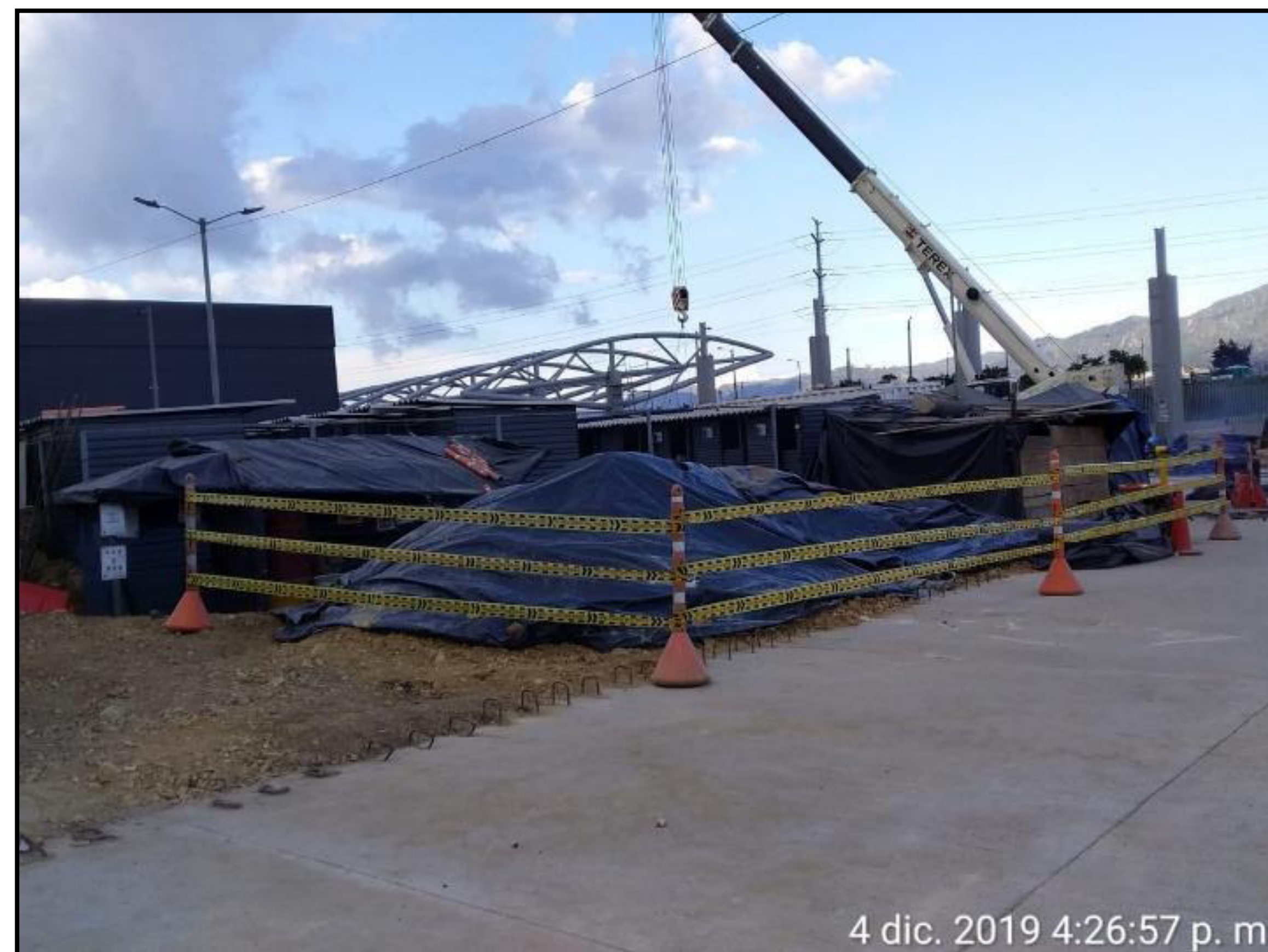
ACOPIO DE MATERIALES GRANULARES
