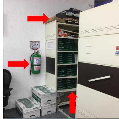
Estantería deformada por el peso de materiales de archivo, cajas de equipos sobre el cerramiento de la estantería y extintor de agua para atender emergencia en caso de incendio.
