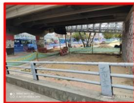
Zona bajo el puente sur
