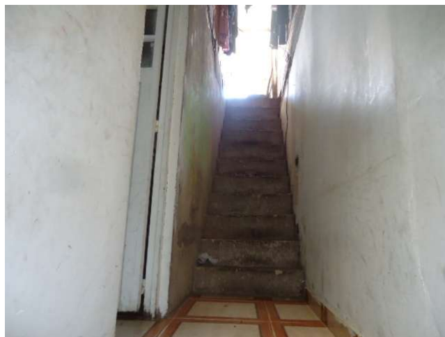
Escaleras a tercer piso
