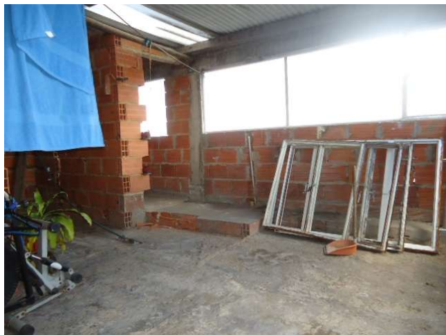
Vista Interna cuarto piso
