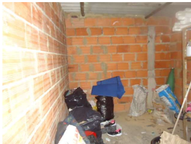
Habitación cuarto piso
