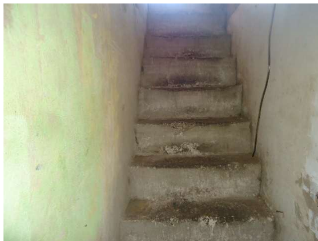
Escaleras a cuarto piso
