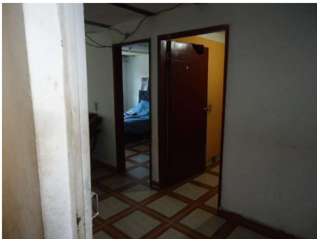
Hall tercer piso
