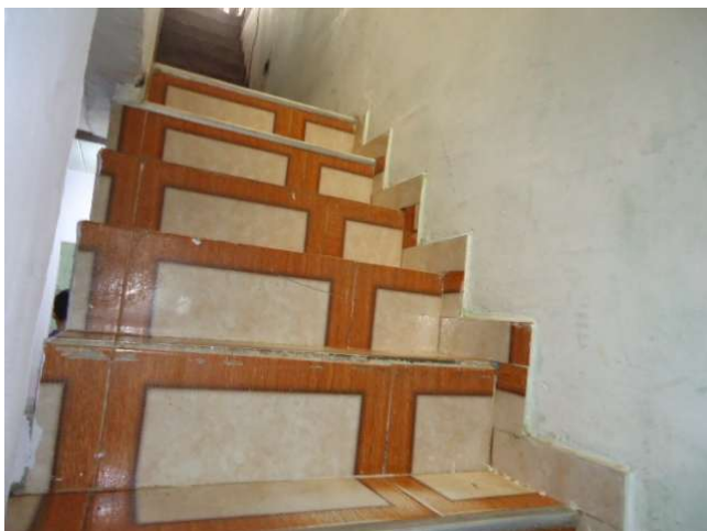
Escaleras segundo piso
