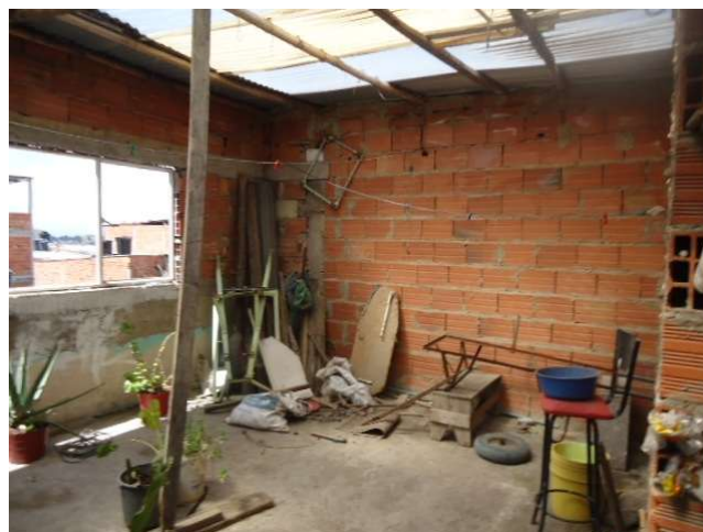
Vista Interna cuarto piso
