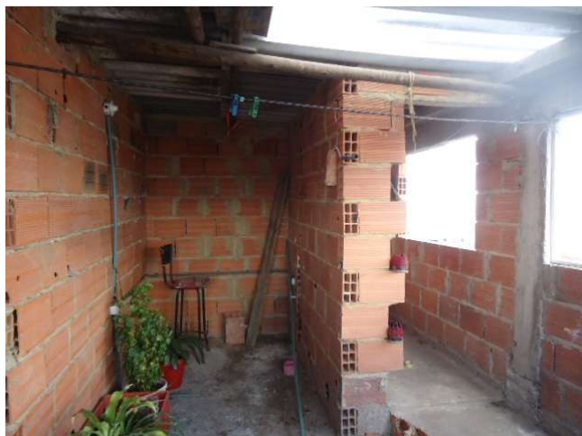
Vista Interna cuarto piso
