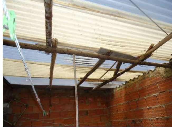
cubierta cuarto piso
