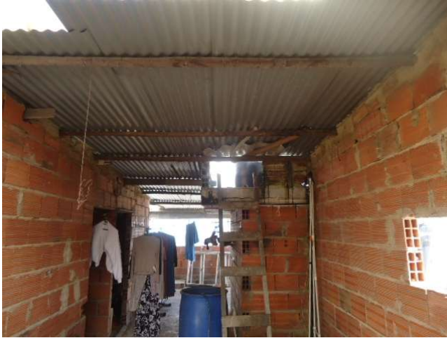
Vista Interna cuarto piso
