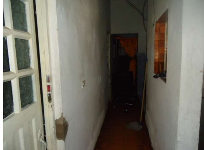
pasillo Primer piso
