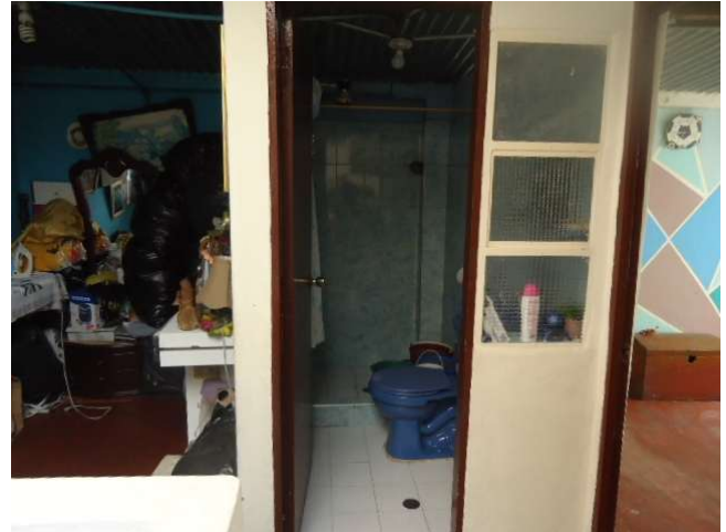
Baño segundo piso
