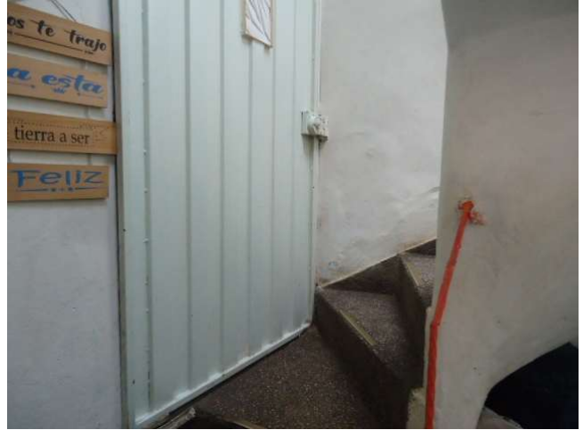
Acceso a segundo piso
