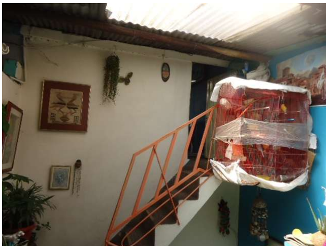
vista interna segundo piso
