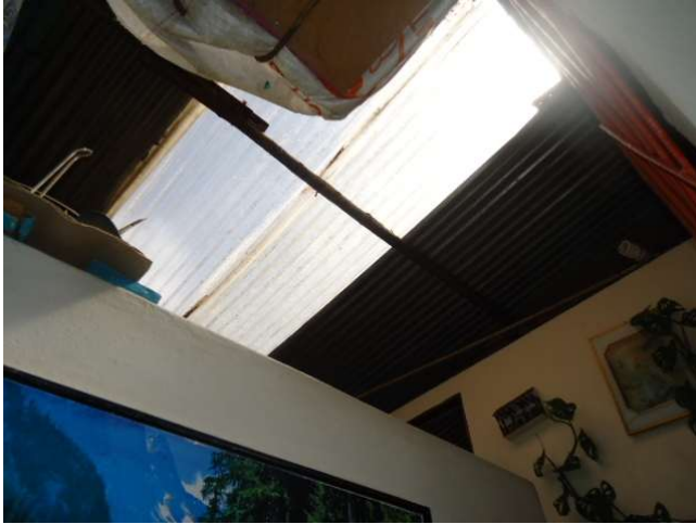
cubierta segundo piso
