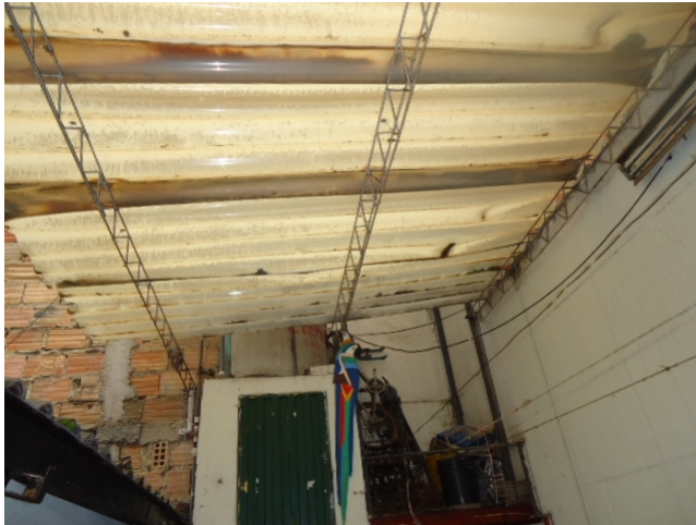
cubierta piso teja 2H
