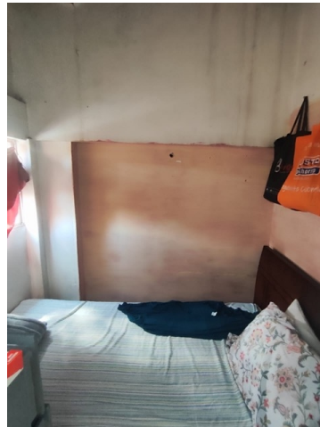
Apartamento segundo piso
