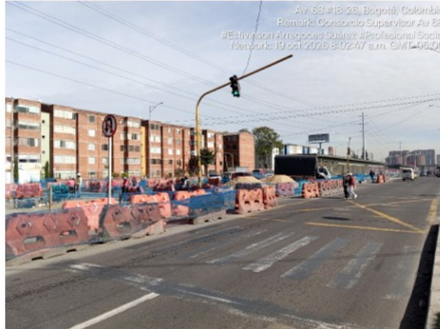
Fotografía Propia Consorcio Supervisor Av. 68. Maletines (Buen estado) Calle 18 sur - carrera 68 sentido sur – norte - Carriles Mixtos En construcción
