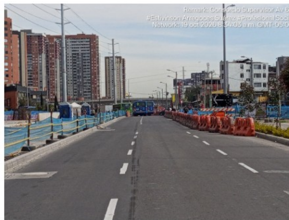
Fotografía Propia Consorcio Supervisor Av. 68. Maletines (Buen estado) Calle 4 sur - carrera 68 sentido sur - norte - Carriles Mixtos
