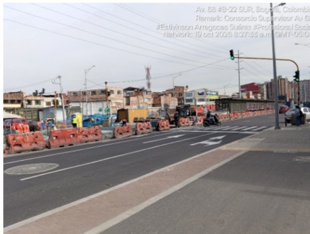
Fotografía Propia Consorcio Supervisor Av. 68. Maletines (Buen estado) Calle 8 sur - carrera 68 sentido sur - norte - Carriles Mixtos En construcción
