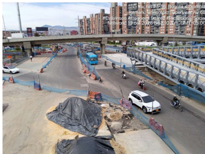
Fotografía Propia Consorcio Supervisor Av. 68. Carrera 68 con calle 3 sentido sur – norte, zona baja del puente vehicular de la calle 3 – en obra
