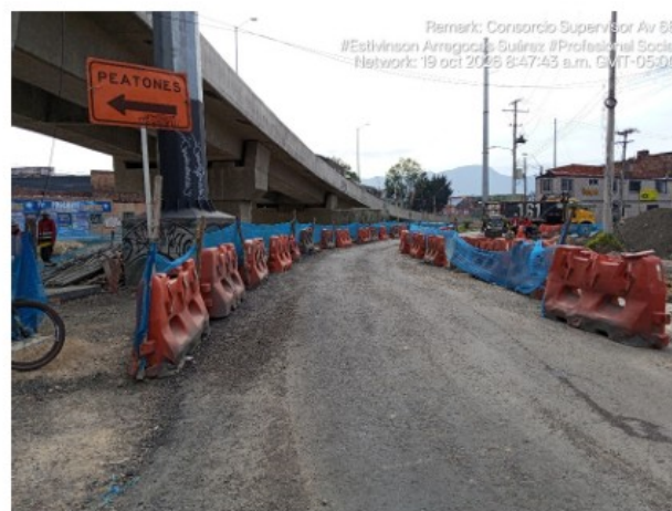
Fotografía Propia Consorcio Supervisor Av. 68. Carrera 68 con Diagonal 2 y calle 3 sentido sur – oriente, zona baja del puente vehicular de la calle 3 – en obra
