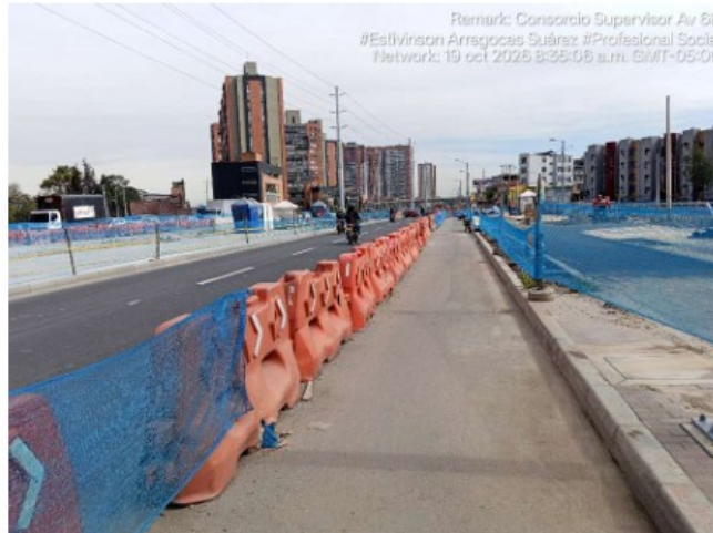
Fotografía Propia Consorcio Supervisor Av. 68. Maletines (Buen estado) Calle 1 sur - carrera 68 sentido sur - norte - Carriles Mixtos
