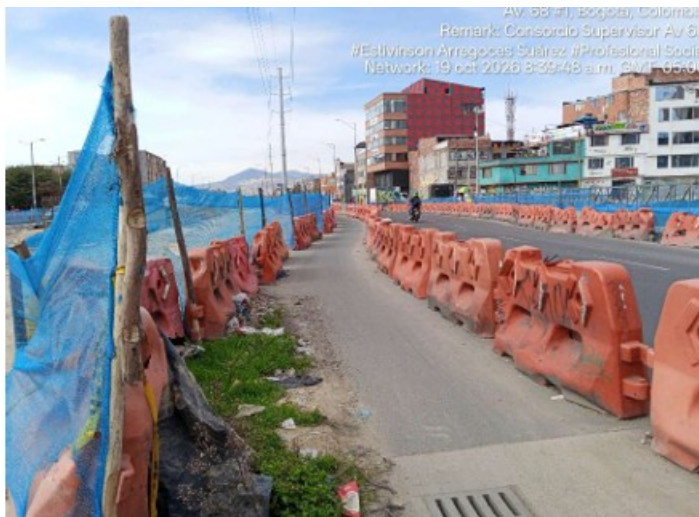
Fotografía Propia Consorcio Supervisor Av. 68. Maletines (Buen estado) Calle 1 - carrera 68 sentido norte - sur - Separador Central
