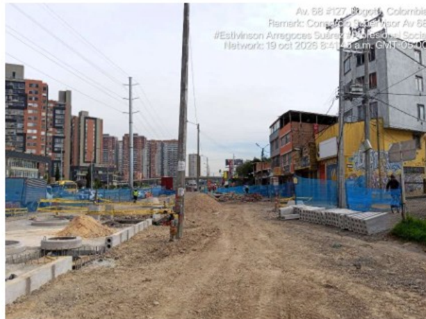
Fotografía Propia Consorcio Supervisor Av. 68. Carriles Mixtos y Conectante de la calle 1 con carrera 68 sentido sur - oriente En construcción
