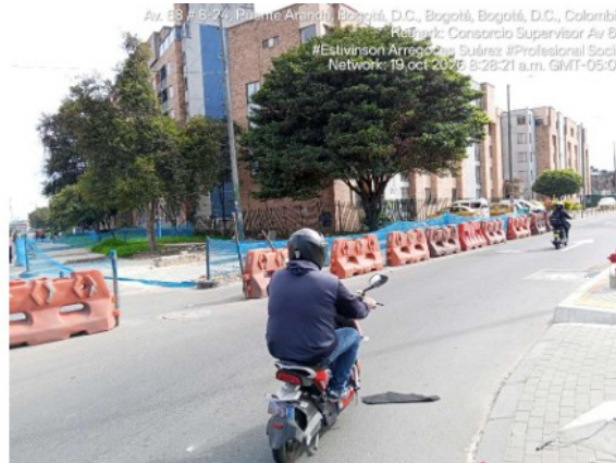
Fotografía Propia Consorcio Supervisor Av. 68. Maletines (Buen estado) Calle 8 sur - carrera 68 sentido sur - oriente - Carriles Mixtos En construcción
