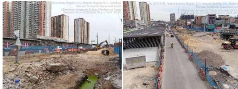
Fotografía Propia Consorcio Supervisor Av. 68. Carrera 68 con calle 4b sentido Sur – Norte en construcción
