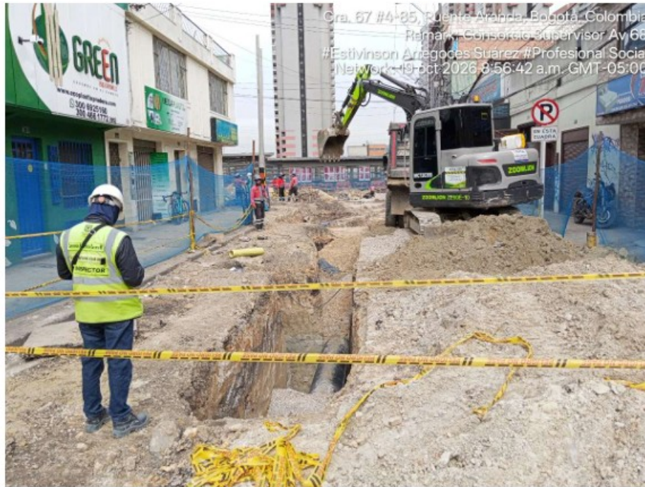
Fotografía Propia Consorcio Supervisor Av. 68. Carrera 68 con calle 4B sentido sur – oriente – en obra
