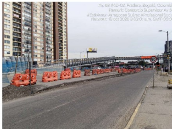
Fotografía Propia Consorcio Supervisor Av. 68. Carrera 68 con calle 4g sentido Sur – Norte en construcción
