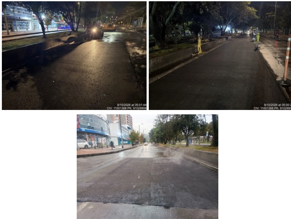
Registro fotográfico Calle 169B entre Carrera 65 y Carrera 67. Costado norte y sur.
