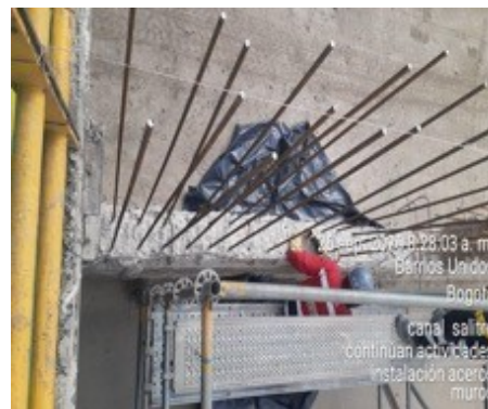
Ilustración Perforación en pantallas existentes C, D y E
