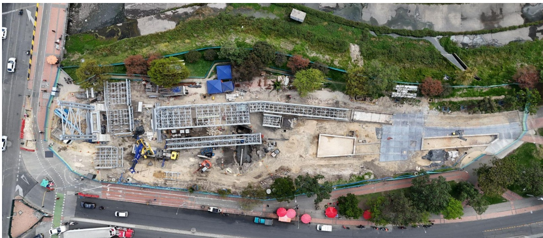
Fotografía N°3: Actividades ejecutadas en el costado oriental (27/10/2026)
