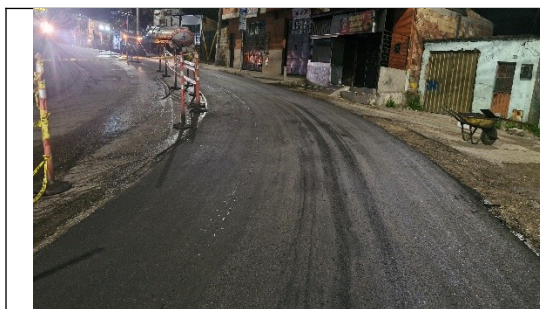
Actividades de fresado Carrera 13 b este con calle 46 sur
