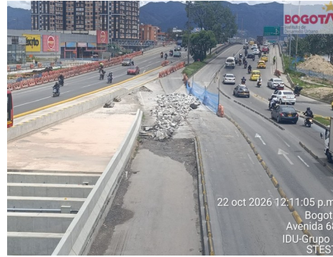
inicio demolición y trabajos sobre paso anterior
