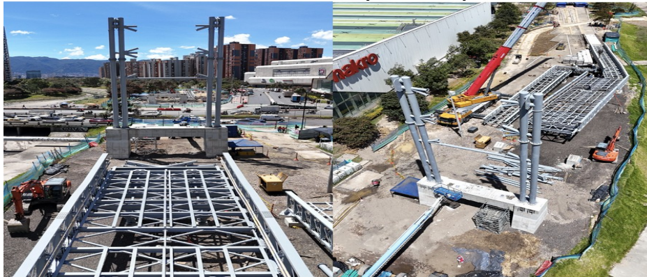
Fotografía N°1: Instalación de estructura del mástil principal sobre las columnas del costado occidental. (08/10/2026)
