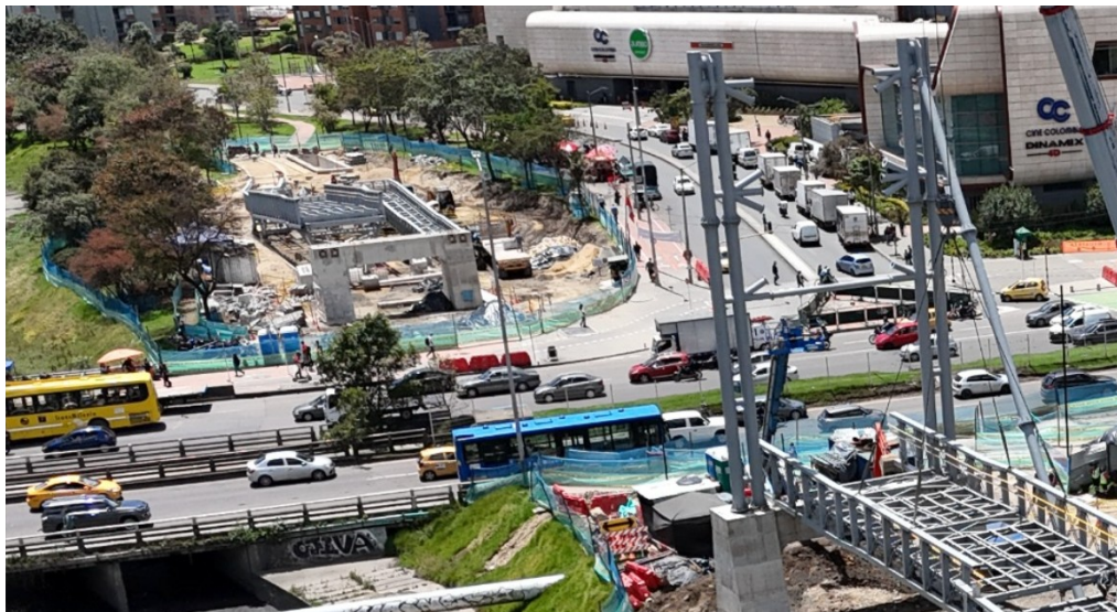
Fotografía N°4 Estado actual costado oriental. (16/10/2026)
